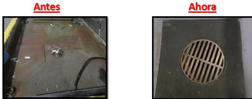
Figura N° 56: Ranura de Drenajes
