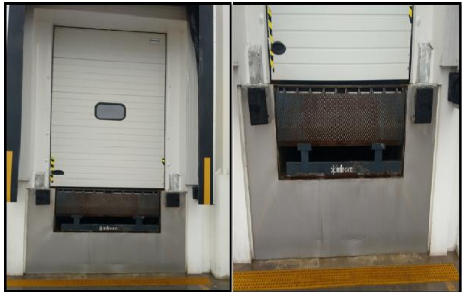
Figura N° 57: Puertas en la Sala de Picking
