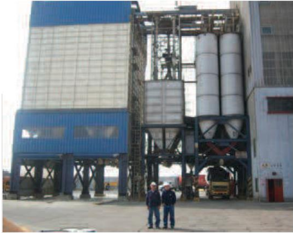
Figura N° 06: Planta de Alimentos San Fernando
