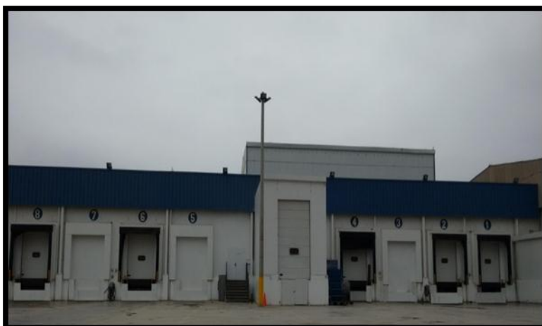
Figura N° 41: Vista de Cámara 1
