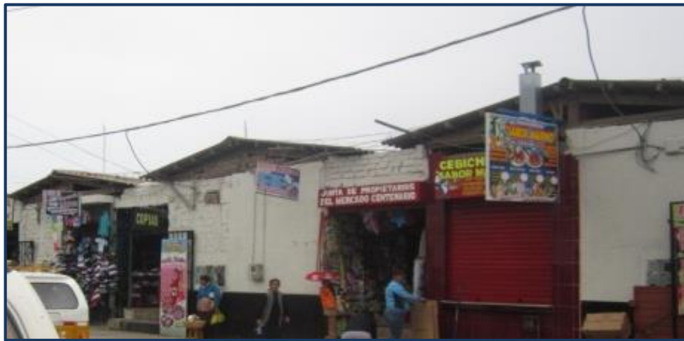
Imagen 34: Fachada Lateral Avenida Nicolas De Pierola Fuente: Fotografía Propia
