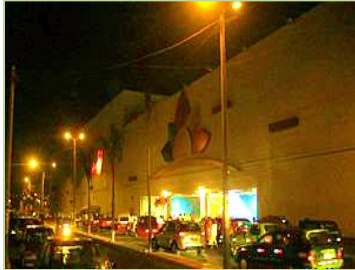
Imagen 25 : Fachada Principal del Sol de Huacho Fuente: Fotografía Propia
