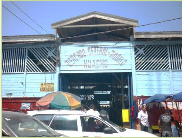
Imagen 30: Fachada Principal, Por La Avenida La Merced Fuente: Fotografía Propia
