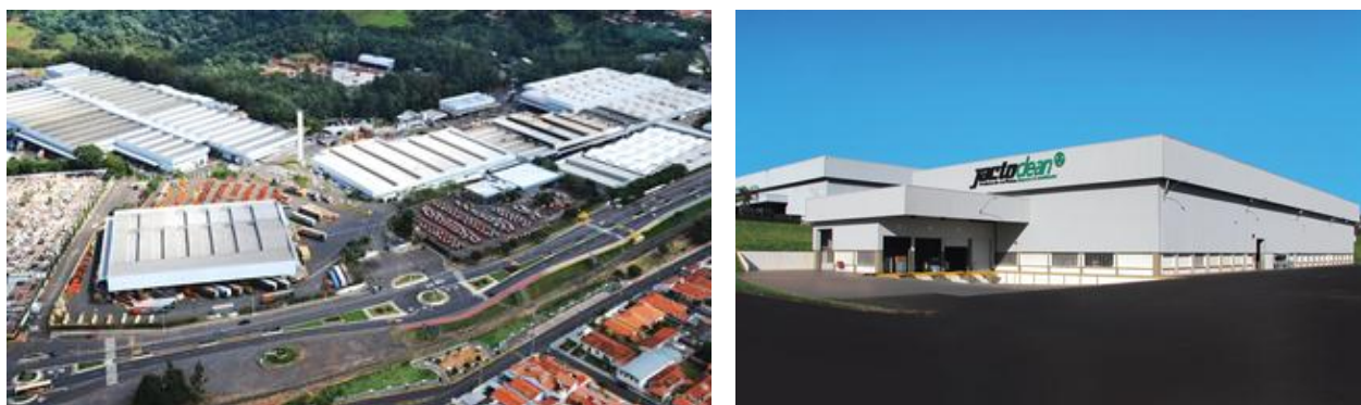
FIGURA Nº11: VISTA PANORÁMICA DE LA FÁBRICA MAQUINARIAS AGRICOLAS JACTO S.A
