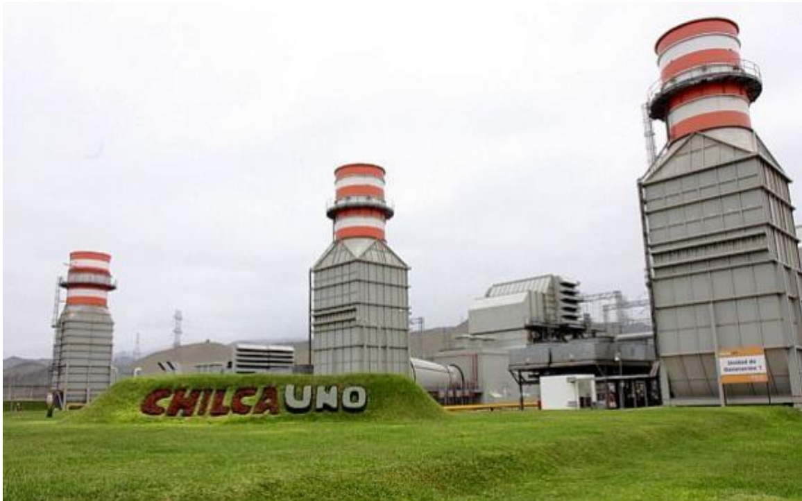
Figura 3.5: Central térmica Chilca UNO.
