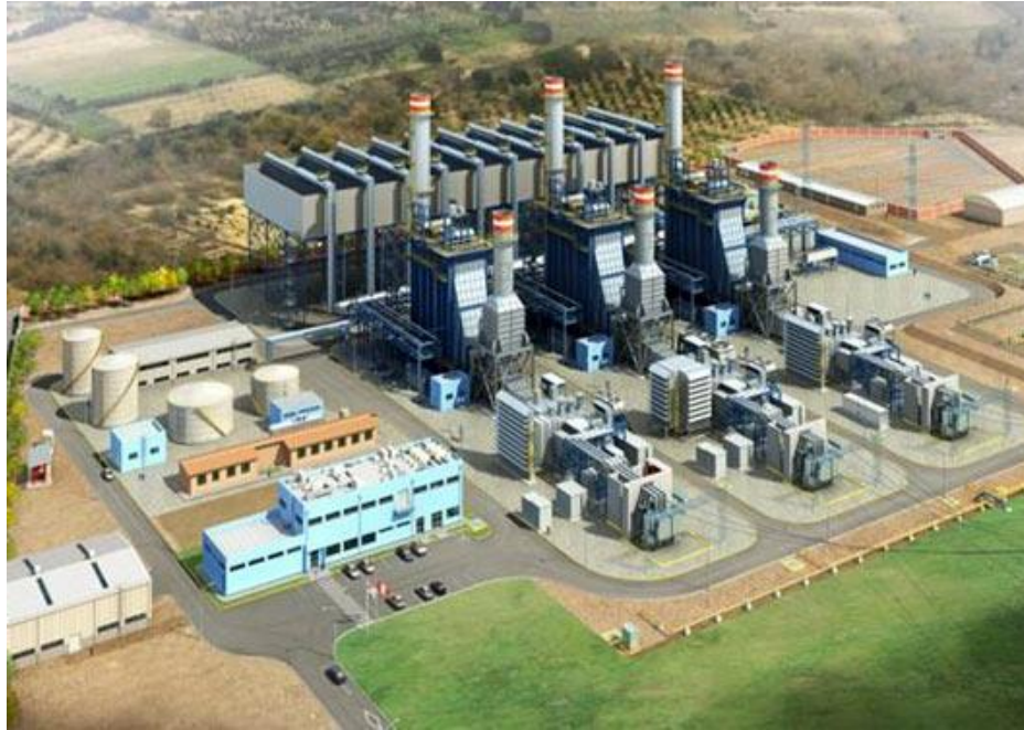
Figura 3.4: Central térmica Kallpa. Fuente; (OSINERGMINa, 2018)
