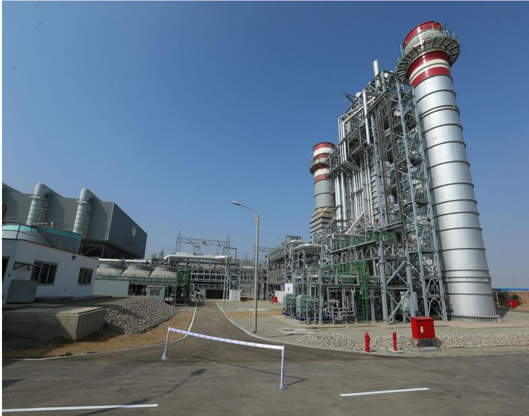
Figura 3.9: Central térmica Santo Domingo de los Olleros. Fuente: (OSINERGMINb; 2018)
