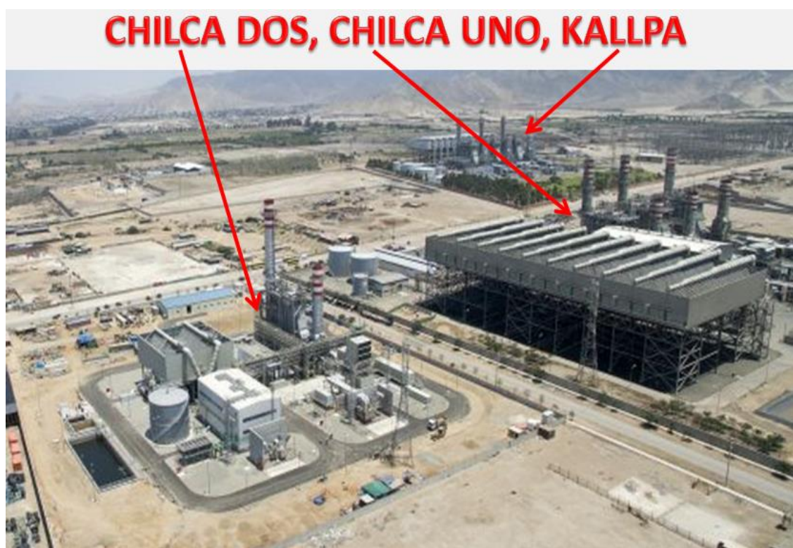
Figura 3.6: Centrales térmicas Chilca 1, Chilca 2 y Kallpa Fuente: (Engie Perú, 2018).
