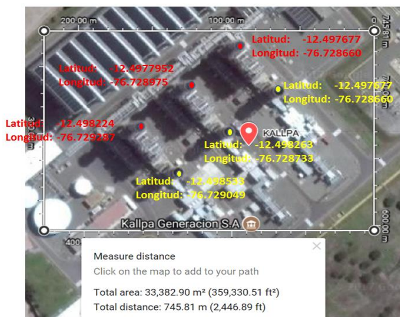
Figura 3.38: Coordenadas geográficas de las Chimeneas de la central térmica Kallpa.
