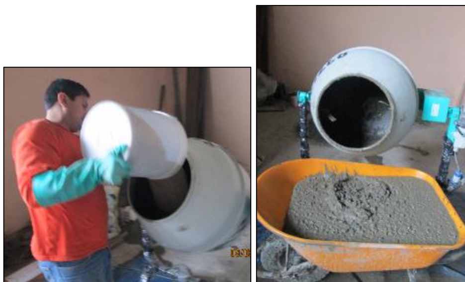
Figura 15 : Carguío de los materiales al mezclador y descarga de concreto. Fuente : El autor
