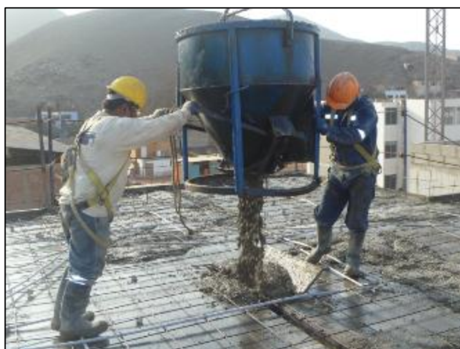
Figura 2 : Colocación de concreto en una proyecto de viviendas de Lima. Fuente : El autor
