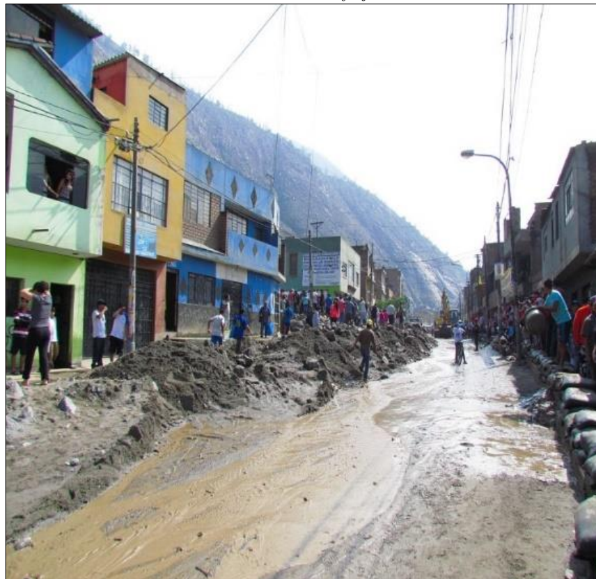
Fotografía N°9-Carretera Central (Av. Independencia) cubierta de lodo, gran cantidad aluvional, que no permite el tránsito vehicular, a consecuencia del flujo de detritos acaecidos el 23-03-2015
