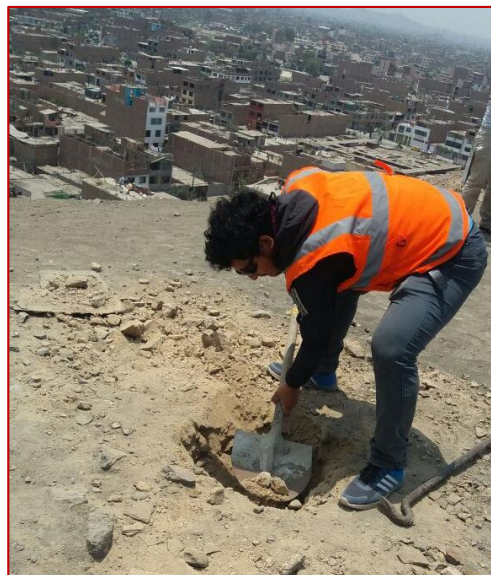
Foto N° 8: Preparación del hueco para el pilar de concreto
