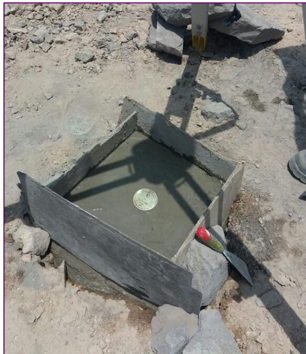
Foto N° 12: Pilar de concreto finalizado
