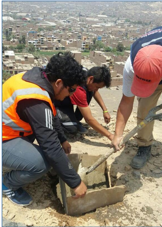
Foto N° 11: Echando concreto para la monumentación
