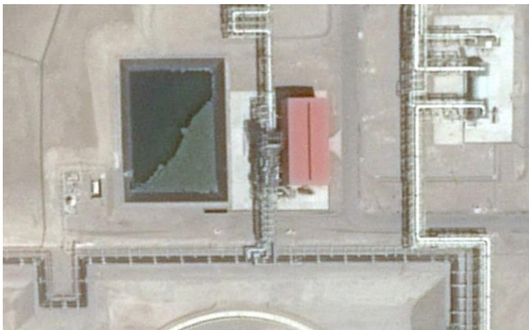
Figura 14: Área de Separador CPI y rack de tuberías Fuente: CPI Warley Parsons Basic Engineering
