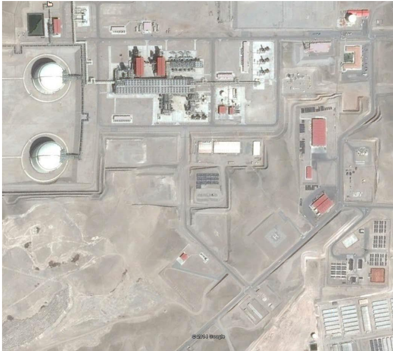
Figura 13: Vista de la locación del proyecto Fuente: CPI Warley Parsons Basic Engineering
