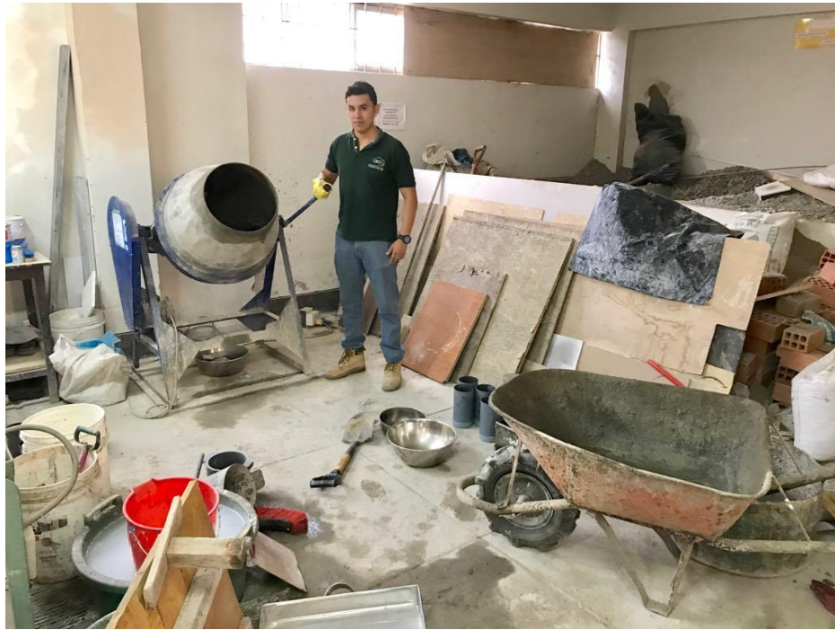
Mezcla del concreto y buggy receptor de la mezcla.
