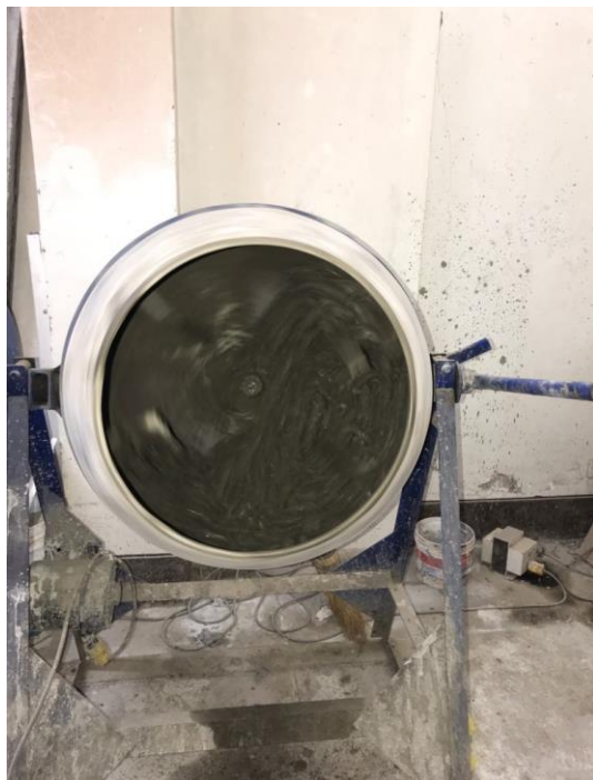
Mezcla del concreto.
