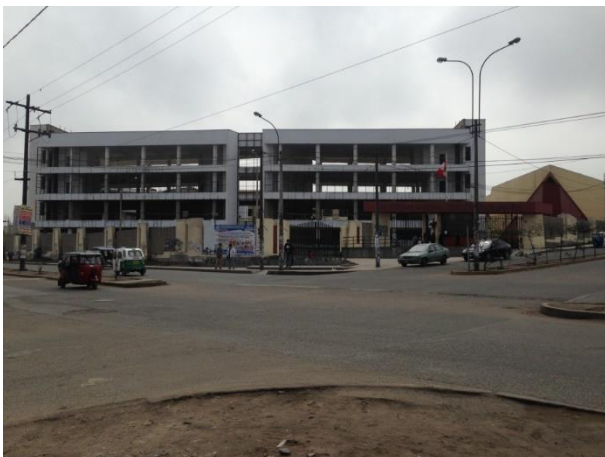
Figura 51. Fotografía del punto A, vista a Universidad Nacional Tecnológica de Lima Sur Fuente: Elaboración propia
