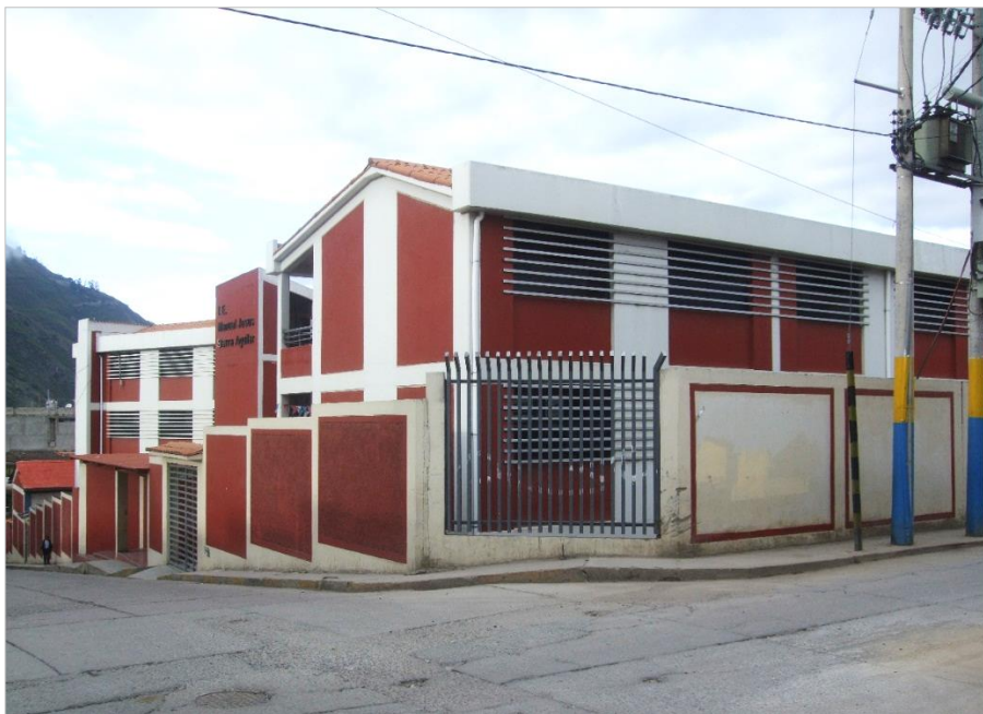
Fotografía 02: I.E. Manuel Jesús Sierra Aguilar, nivel inicial, primaria y secundaria. Edificación de 2 plantas, Jr. Díaz Bárcenas S/N. Fuente: Elaboración Propia.
