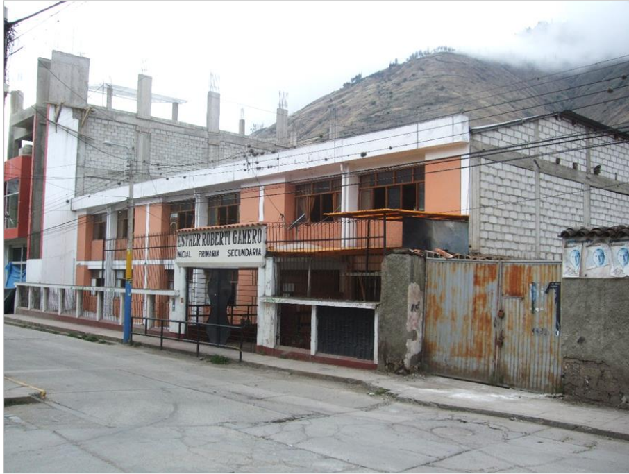
Fotografía 05: I.E. Esther Roberthi Gamero, nivel inicial, primaria y secundaria. Edificación de 3 plantas, Jr. Puno N° 211.
