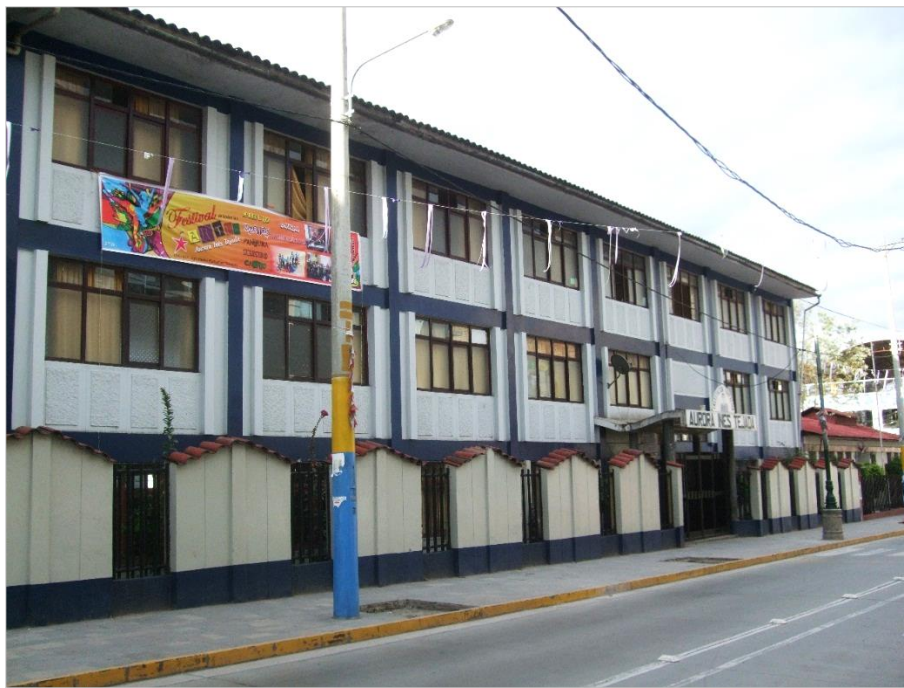
Fotografía 04: I.E. Aurora Inés Tejada, nivel primaria y secundaria. Edificación de 3 plantas, Jr. Arequipa N° 101. Fuente: Elaboración Propia.
