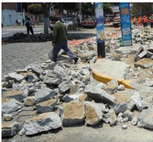
Fotografía N° 1: Demolición de veredas en el distrito de El Agustino.
