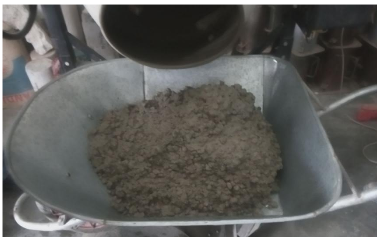
Fotografía N° 19: Colocación del concreto en una carretilla limpia.
