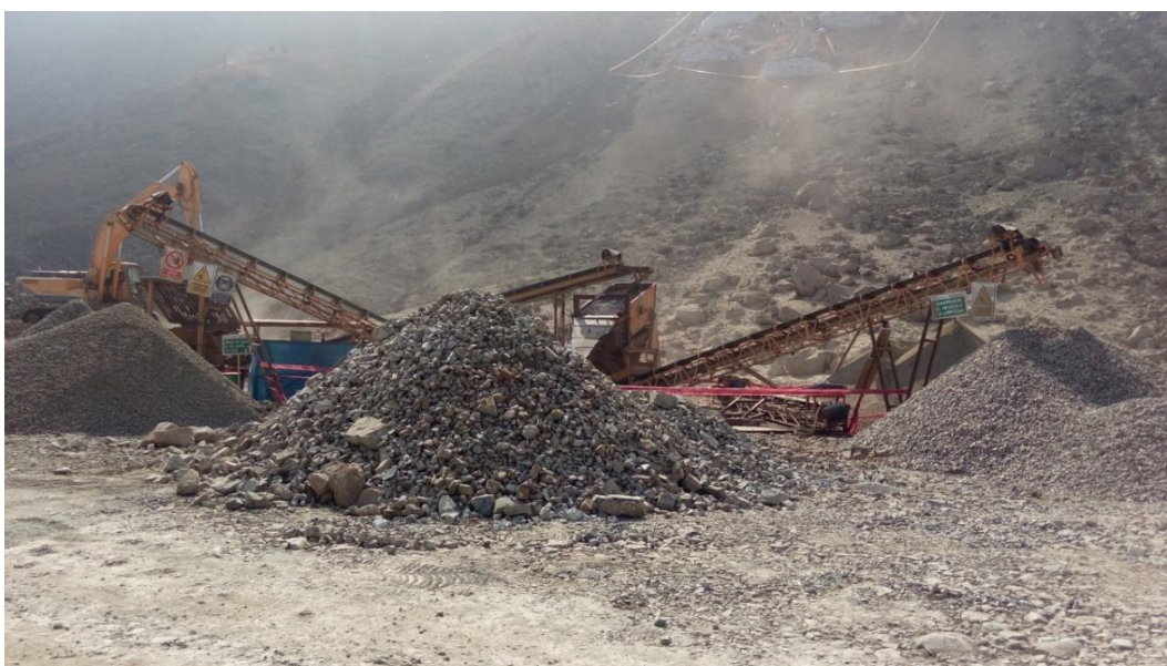
Fotografía N° 2: Trituración de bloques de concreto para la obtención de agregados finos y gruesos reciclados.
