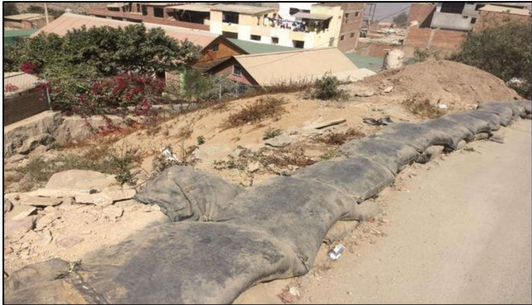
Fotografía N° 25: Costales en las vías para que las viviendas no sean inundadas por las precipitaciones
