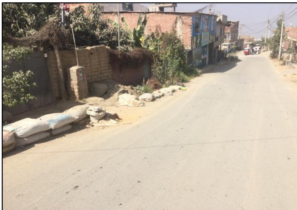
Fotografía N° 4: Viviendas de adobe y material de concreto
