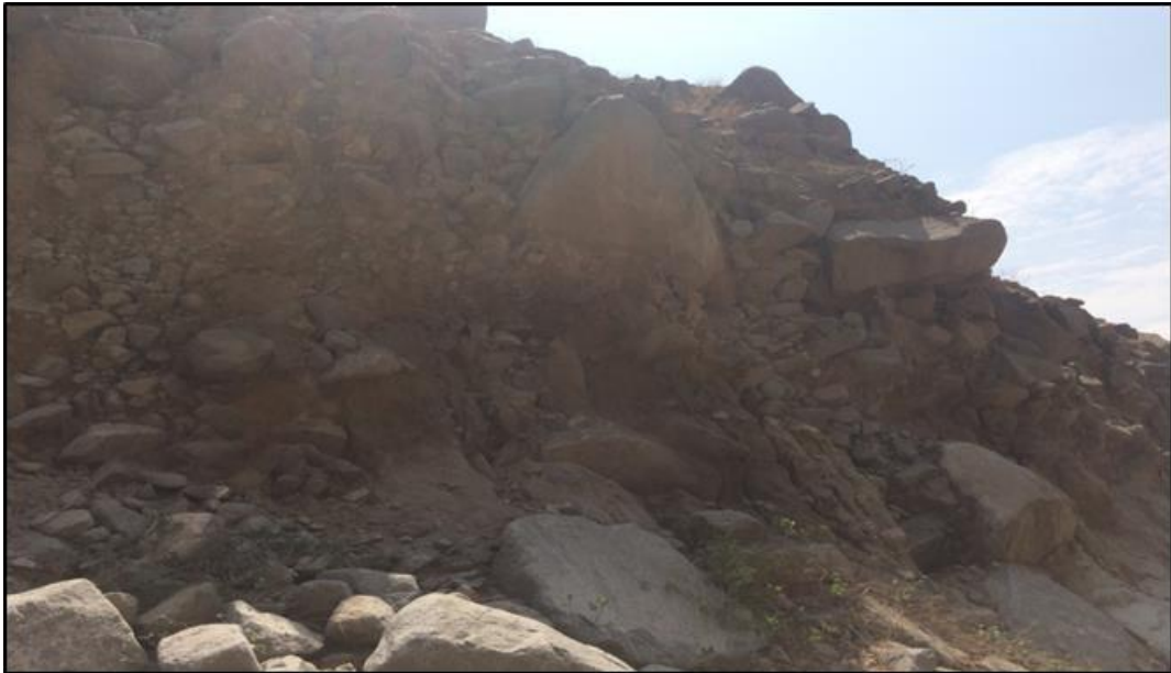
Fotografía N° 27: Laderas del cauce erosionadas y riesgo de derrumbarse
