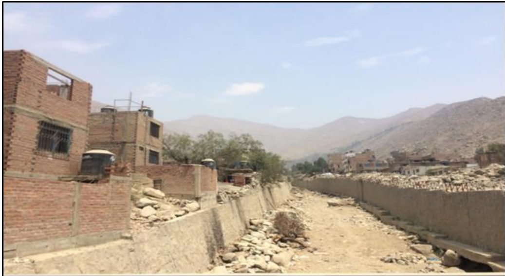
Fotografía N° 12: Construcción de muros en el cauce
