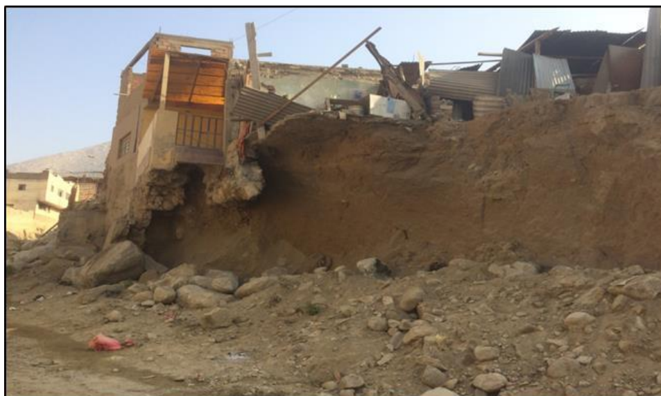
Fotografía N° 10: Vivienda afectada por el caudal
