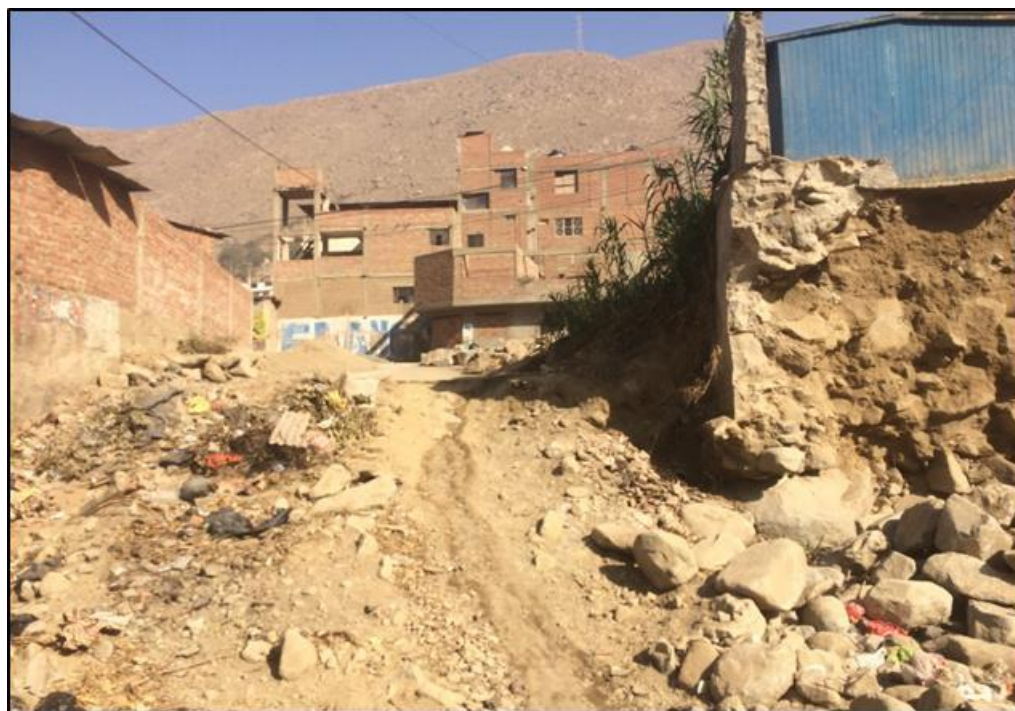
Fotografía N° 6: Otra carretera dentro del cauce (badén)
