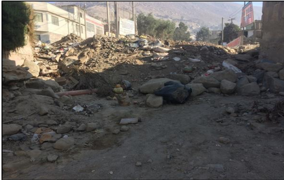
Fotografía N° 8: Presencia de residuos de las actividades de construcción y demolición
