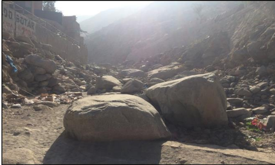
Fotografía N° 14: Rocas de gran dimensión que fueron depositadas en el cauce
