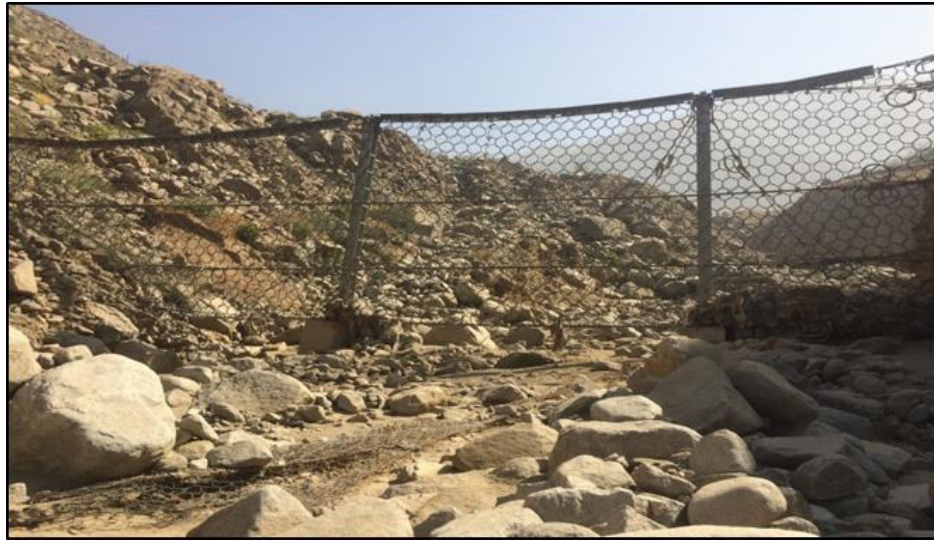
Fotografía N° 17: Malla N° 1 ubicado en el cauce como medida de prevención
