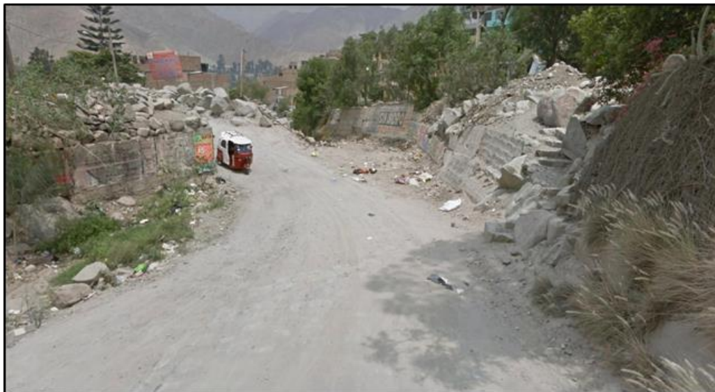
Fotografía N° 5: Carretera dentro del cauce (badén)
