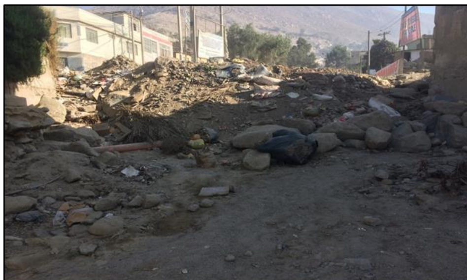
Fotografía N° 11: Residuos de construcción que obstaculizan el cauce
