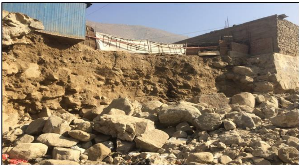
Fotografía N° 13: Vivienda afecta por el arrastre de rocas
