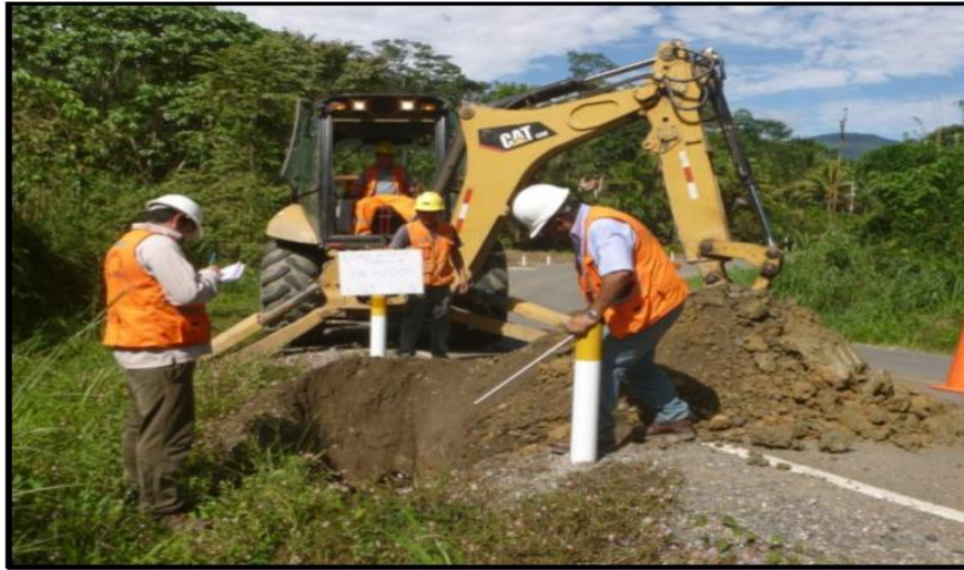
Descripción y Profundidad de la Calicata. Fuente: Propia.
