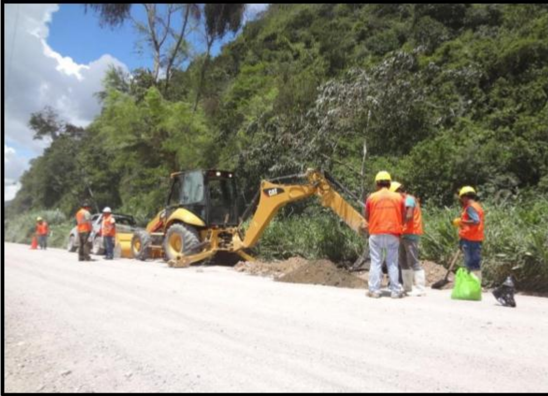
Ensayo destructivo – Calicata. Fuente: Propia.
