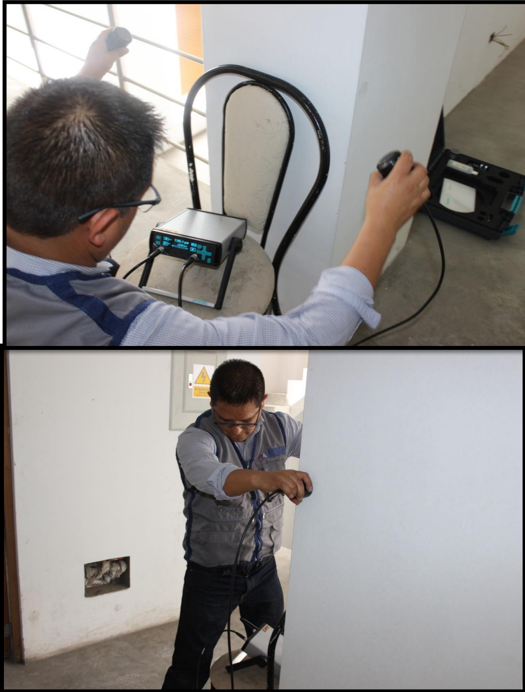
Figura 60: Ensayo de resistencia en compresión del concreto de las estructuras de concreto, del edificio terminado
