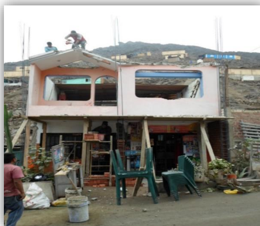
Fotografía 3: Vivienda en proceso de reforzamiento.
