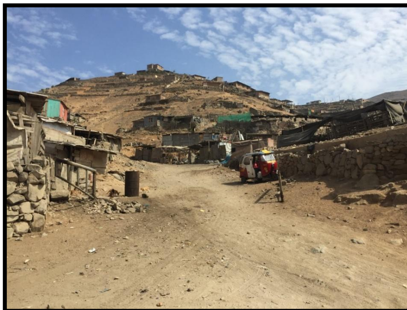
Fotografía N° 1. Vista desde la parte baja de la calle Los Robles de la Asociación Zona Agropecuaria Casa Huerta Granja - V.M.T. - 06/05/2018 (Fuente: Propia)
