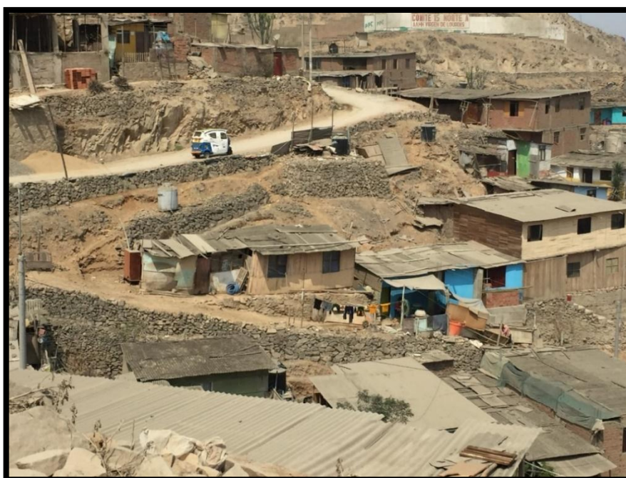
Fotografía N° 18. Vista de viviendas en laderas erosionadas en el Sector 37 - V.M.T. - 17/02/2018 (Fuente: Propia)
