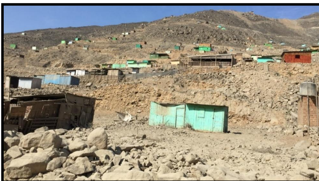
Fotografía N° 13. Vivienda sobre laderas inestables en la Junta de Posesionarios del Parque Industrial - anexo 2 - Manchay - V.M.T. - 06/05/2018 (Fuente: Propia)
