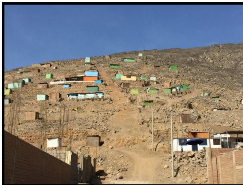
Fotografía N° 7. Viviendas en zonas de alta pendiente en la Junta de Posesionarios del Parque Industrial - anexo 2 - Manchay - V.M.T. - 06/05/2018 (Fuente: Propia)
