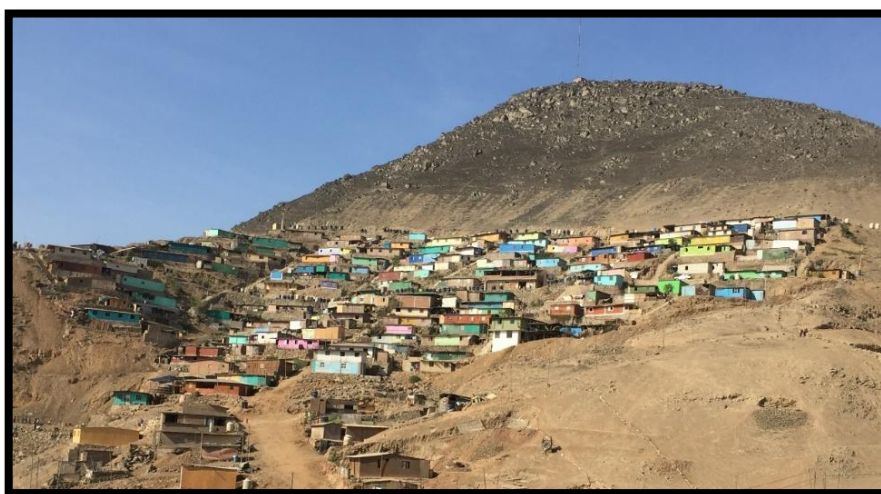
Fotografía N° 26. A.H. Laderas de Villa Jesús de Nazaret, zona de Alto a Muy alto riesgo - V.M.T. - 06/05/2018 (Fuente: Propia)
