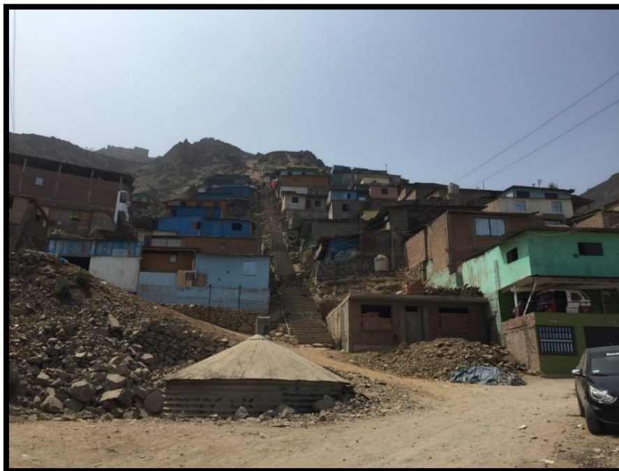
Fotografía N° 19. Vista de la parte frontal alta del Sector 37 - V.M.T. - 17/02/2018 (Fuente: Propia)
