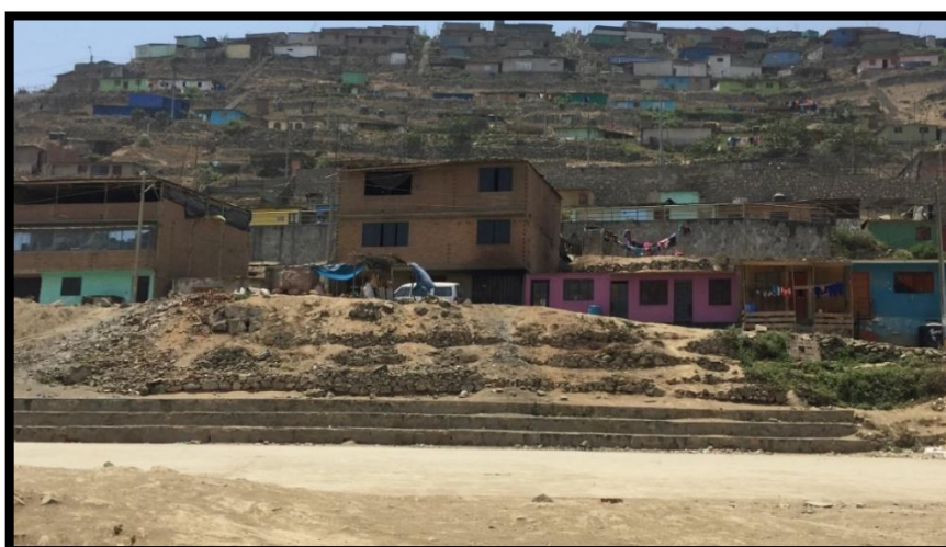
Fotografía N° 10. Vista de la parte alta del margen izquierdo de la Av. Unión en el sector 35 del A. H. Santa María Virgen de Lourdes - V.M.T. - 21/10/2017 (Fuente: Propia)
