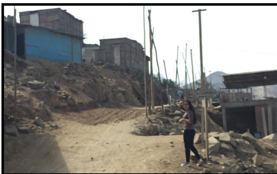
Fotografía N° 25. Viviendas sobre suelo residual en zona de Muy alto riesgo del pasaje Laderas de la Asociación Agropecuaria Casa Huerta Granja - V.M.T. - 06/05/2018 (Fuente: Propia)
