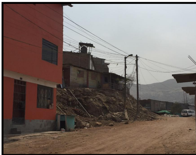
Fotografía N° 10. Viviendas sobre ladera inestable en el Jr. El Corregidor en el sector 38 del P.J Virgen de Lourdes - V.M.T. - 17/02/2018 (Fuente: Propia)
