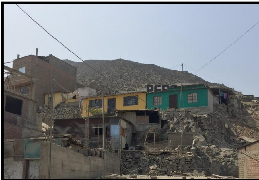
Fotografía N° 15. Viviendas en zona de desprendimiento de rocas en el Psje. Buena Vista del P.J Virgen de Lourdes - V.M.T. - 17/02/2018 (Fuente: Propia)
