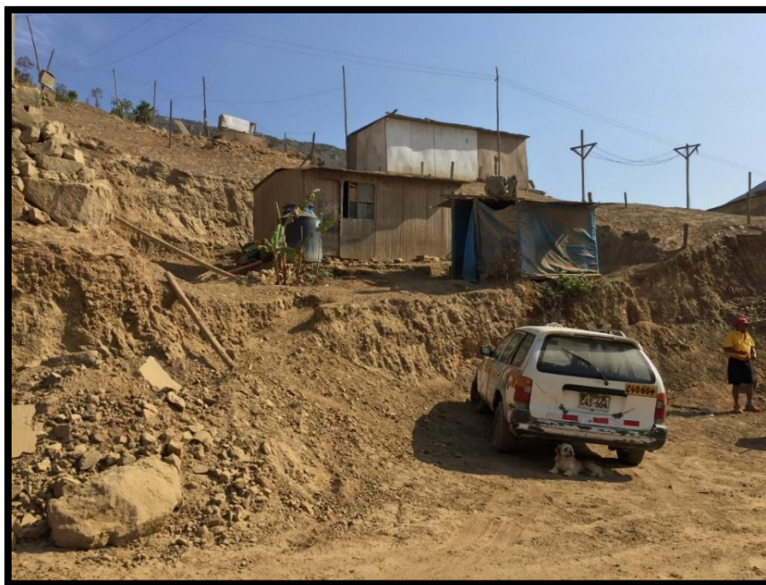
Fotografía N° 3. Vivienda sobre laderas de suelos residuales en el A.H Villa el Pedregal - V.M.T. - 06/05/2018 (Fuente: Propia)
