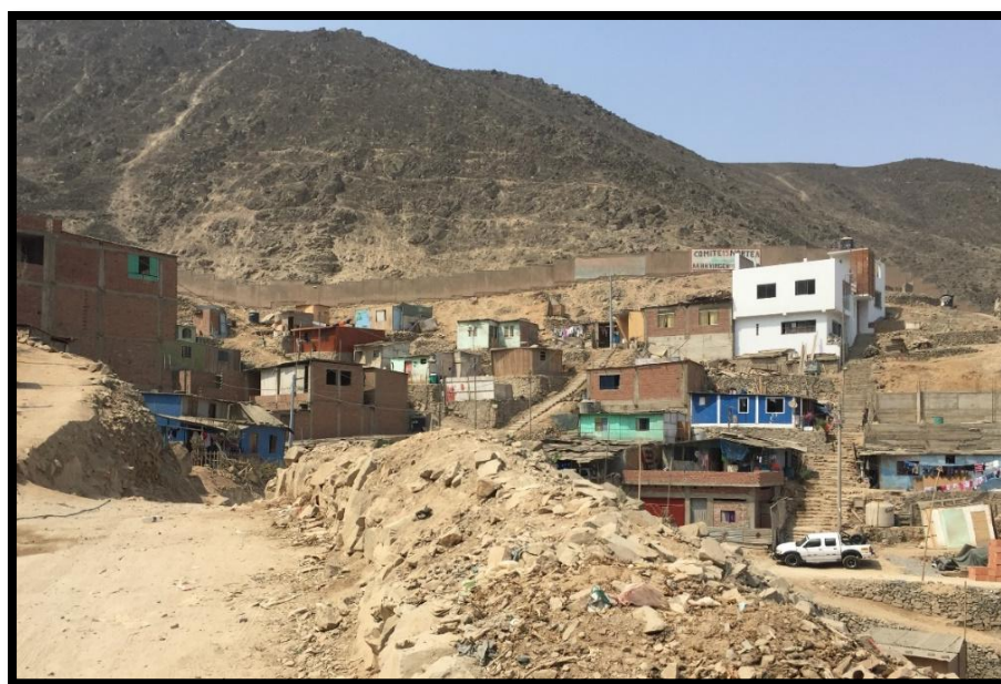
Fotografía N° 16. Vista del comité 15 norte A - V.M.T. - 17/02/2018 (Fuente: Propia)
