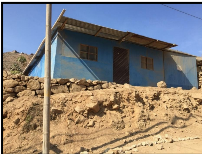
Fotografía N° 5. Vivienda sobre suelo inestable en el A.H Villa el Pedregal - V.M.T. - 06/05/2018 (Fuente: Propia)
