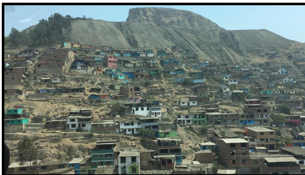
Fotografía N° 4. Vista de los sectores 42 y 43 – V.M.T – 21/10/2017 (Fuente: Propia)
