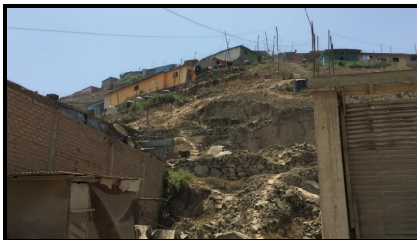
Fotografía N° 16. Viviendas de madera sobre laderas de altas pendientes de formación de suelo residual en el margen izquierdo del A. H. Santa María Virgen de Lourdes - V.M.T. - 21/10/2017 (Fuente: Propia)
