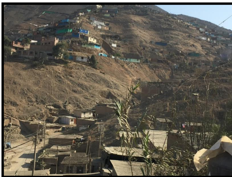
Fotografía N° 7. Viviendas sobre laderas de altas pendientes en el A.H. Villa Lourdes II - V.M.T. - 06/05/2018 (Fuente: Propia)
