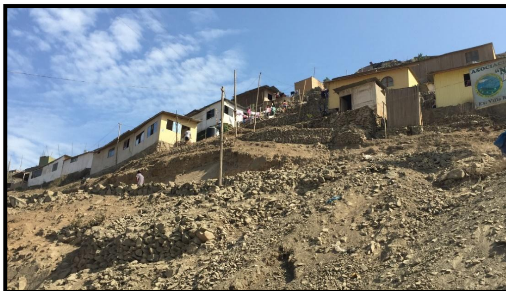
Fotografía N° 14. Viviendas en zonas de alta pendiente con formación de suelos residuales A.V. Nueva Unión - V.M.T. - 06/05/2018 (Fuente: Propia)
