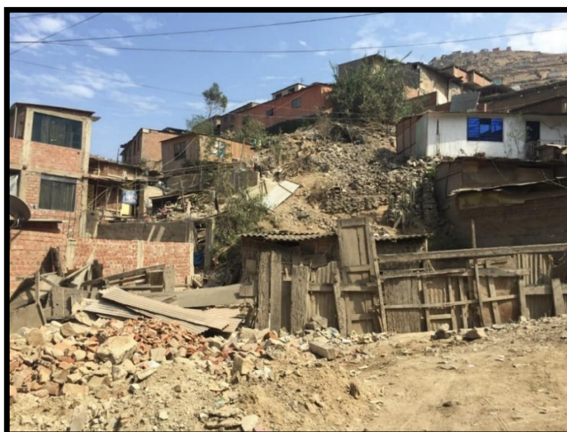
Fotografía N° 2. Viviendas sobre laderas de altas pendientes en la parte derecha de la calle 7 de Junio en el A.H. Nueva Esperanza - V.M.T. - 06/05/2018 (Fuente: Propia)
