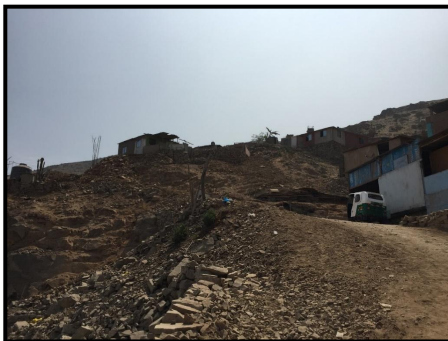
Fotografía N° 6. Viviendas sobre laderas inestables en el Sector 37 – V.M.T – 17/02/2018 (Fuente: Propia)
