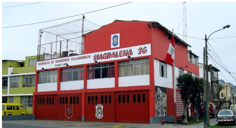
Fotografía N°1: Vista exterior de la Compañía
