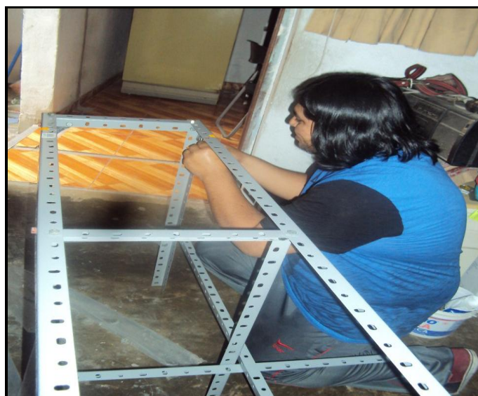
Figura 14. Construcción del andamio.
