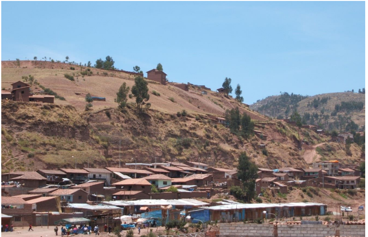
Foto Nro. 18.-El 95% de casas son de adobe y son de autoconstrucción, los materiales son inadecuados. En una topografía agreste de intensa precipitación y de alta sismicidad.
