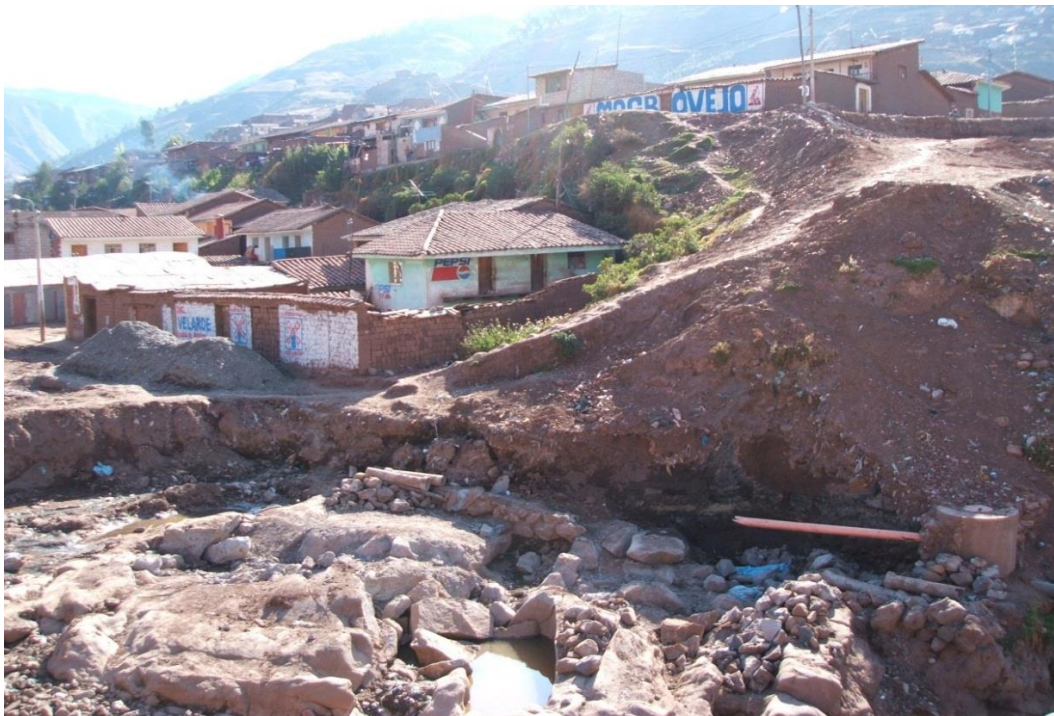
Foto Nro. 14: No existen vías definidas. Los accesos son erosionados por el río Huancaro (en épocas de lluvias), esto dificulta cualquier atención de emergencias.
