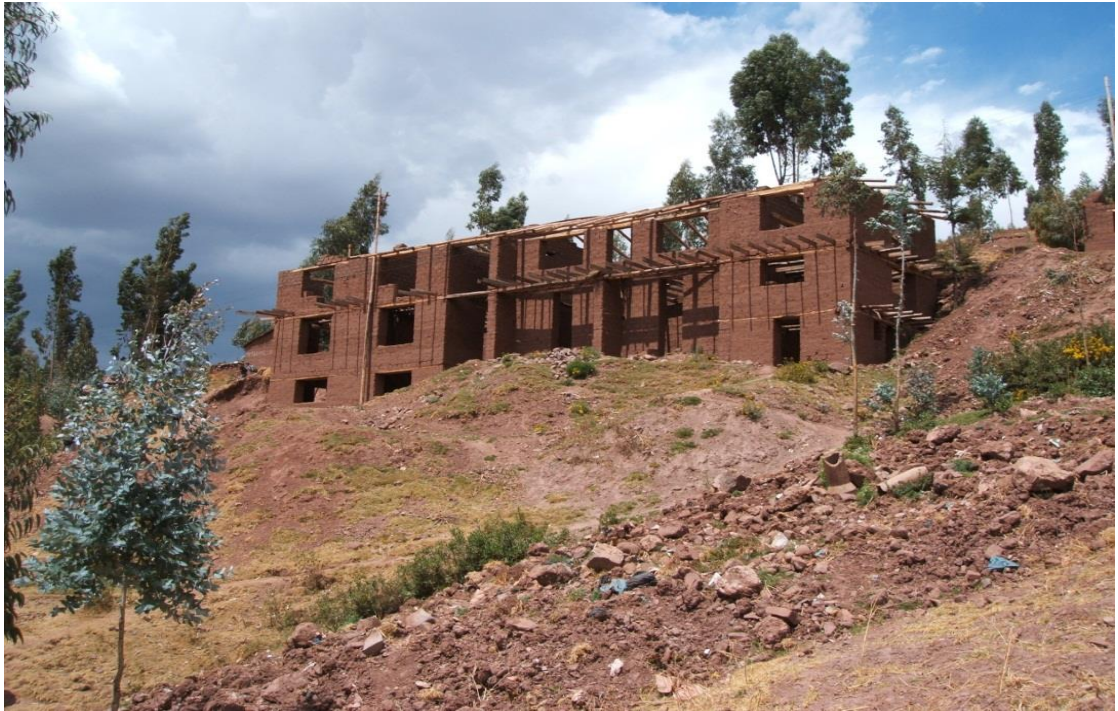
Foto Nro. 13: Construcciones de adobe hasta de tres pisos, en zona de alta sismicidad, constituyen viviendas muy vulnerables.
