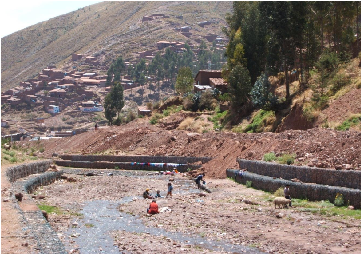
Foto Nro. 17.-Incesante arrojado de desmontes y residuos sólidos en quebradas
