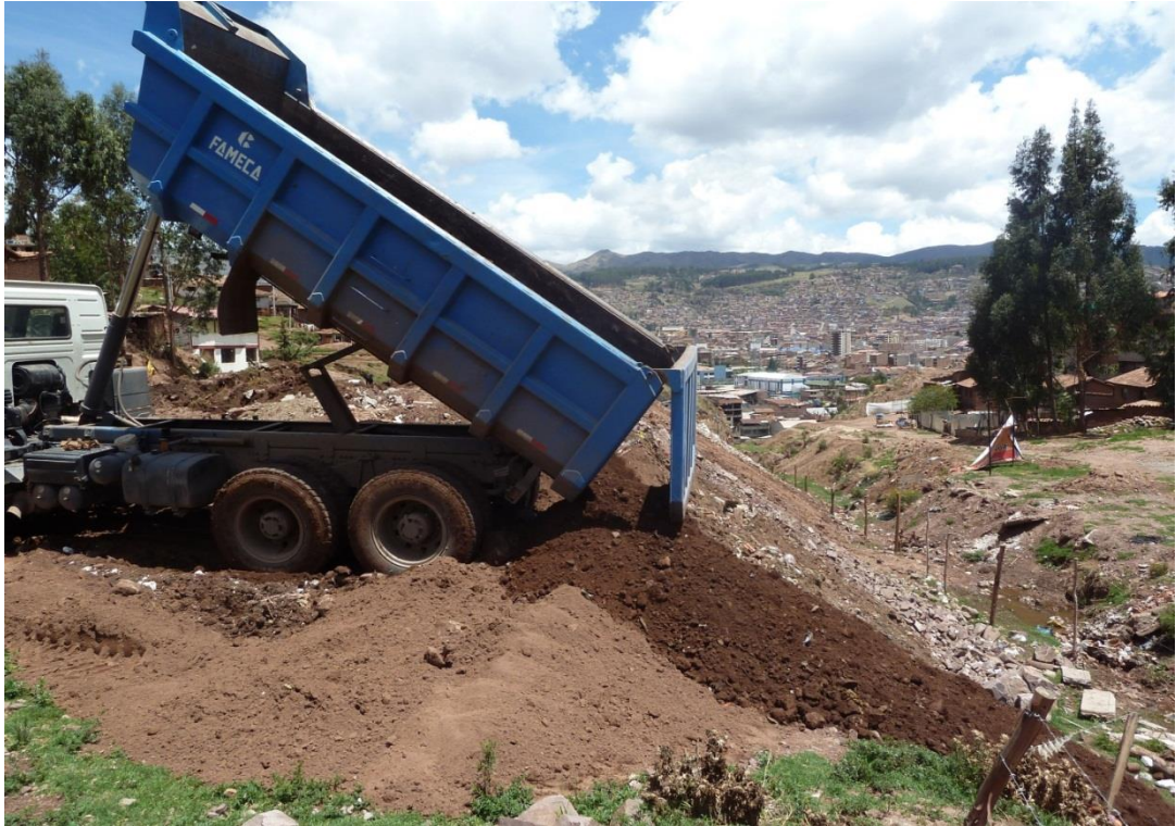
Foto Nro. 20 :Permanente acarreo de materiales de desmonte hacia las quebradas ya queda poco espacio para el dren natural. Igualmente el siguiente paso es la explanacion y la urbanizacion.
