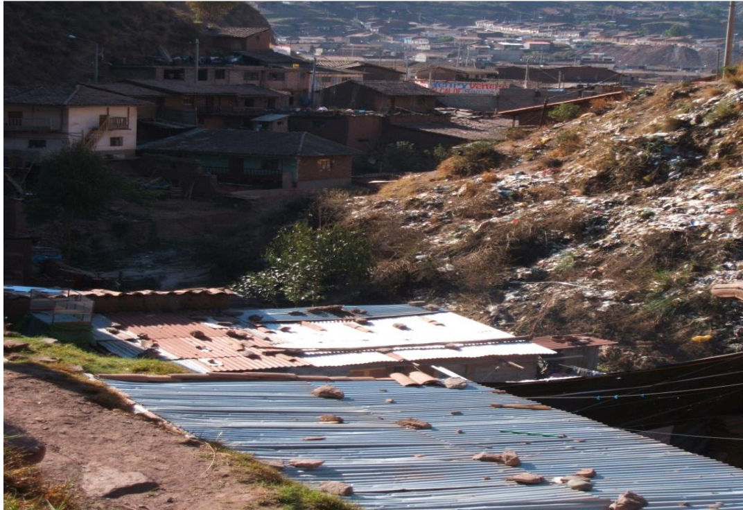
Foto Nro5: Construcciones cerca del cauce del rio Chocco (afluente del rio Huancaro), al pie de laderas y mucha contaminación.
