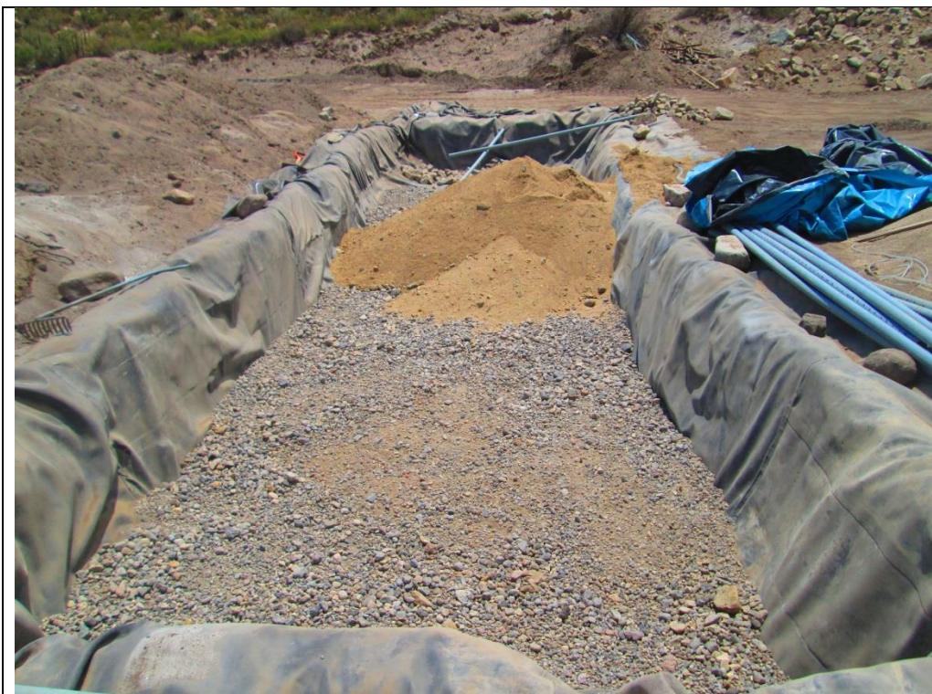
Fotografía N° 14: Colocación de la 1ra capa y 2da capa del sustrato.
