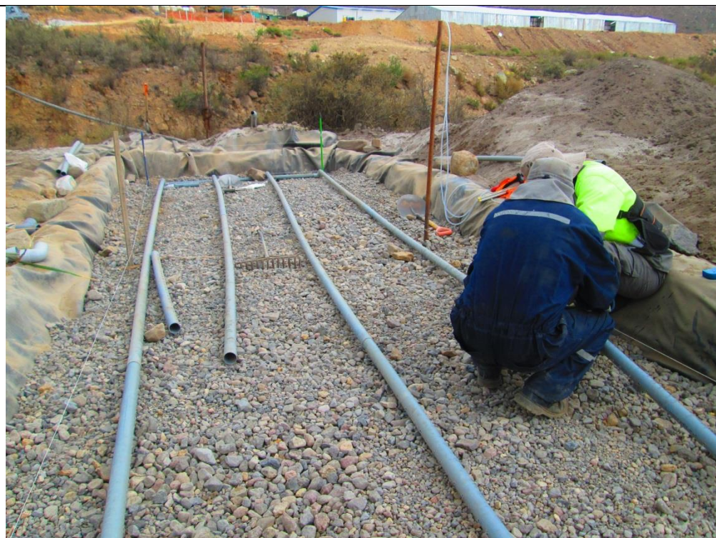
Fotografía N° 17: Colocación de 04 tuberías para la dispersión del ARD por la superficie del humedal.
