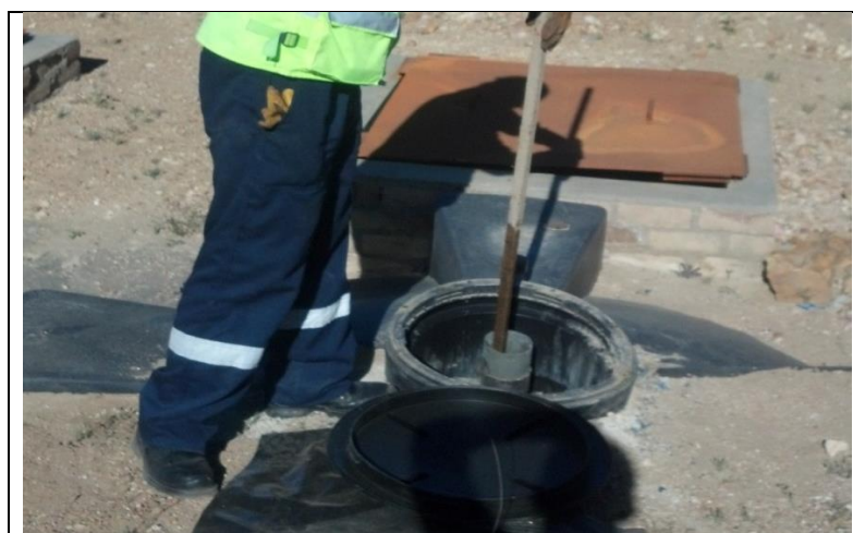
Fotografía N° 21: Mantenimiento de biodigestores Rotoplast.
