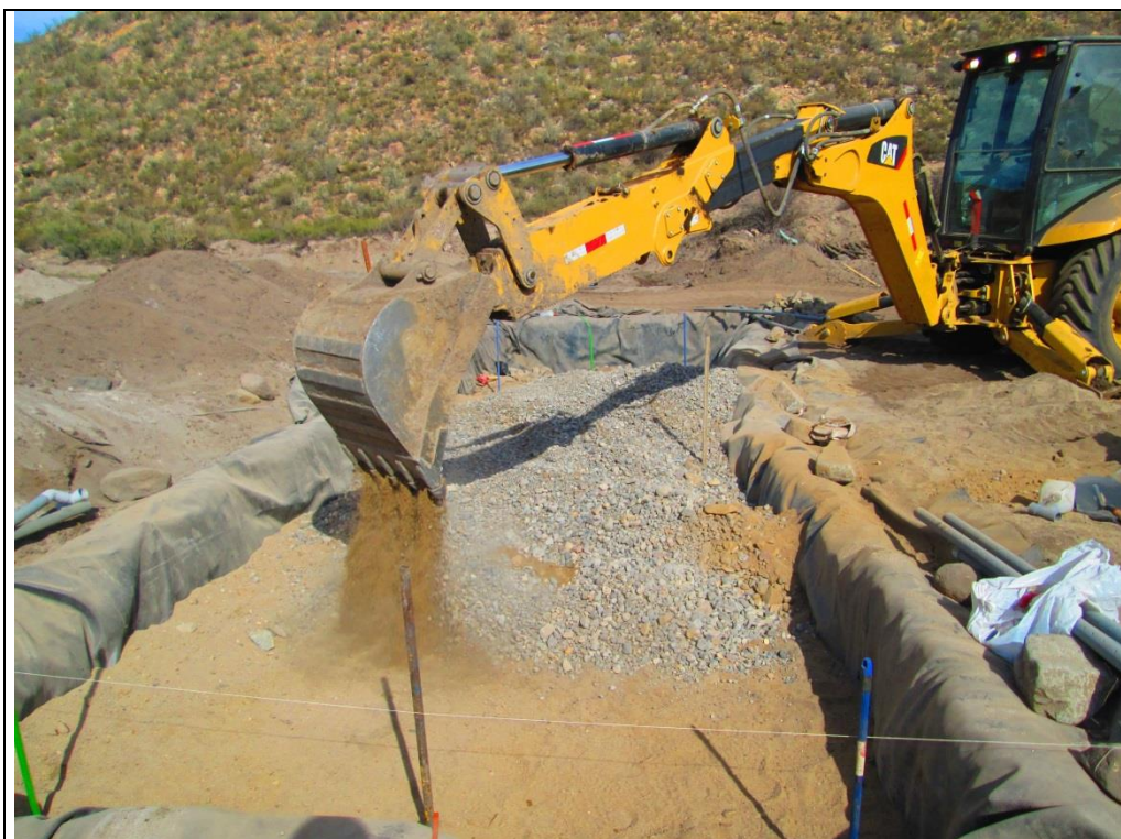
Fotografía N° 16: Colocación de la 3ra capa y 4ta capa del sustrato.
