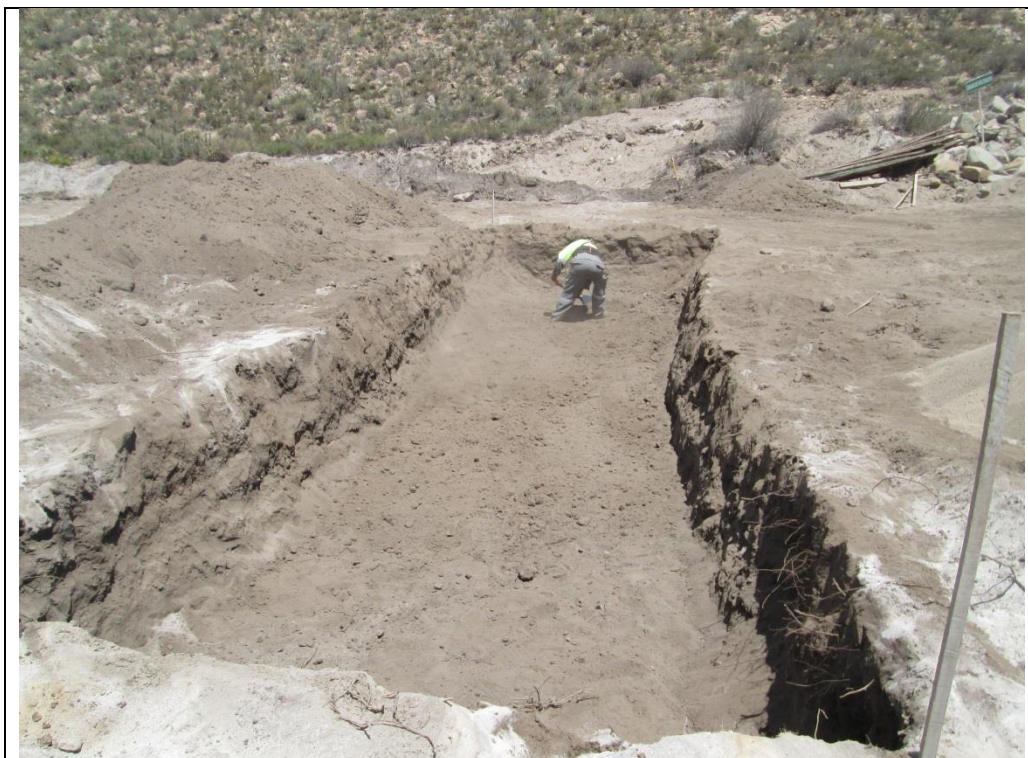
Fotografía N° 11: Extracción de tierra y piedras
