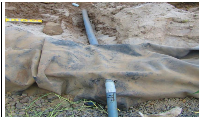
Fotografía N° 20: Acople de tuberías al sistema.
