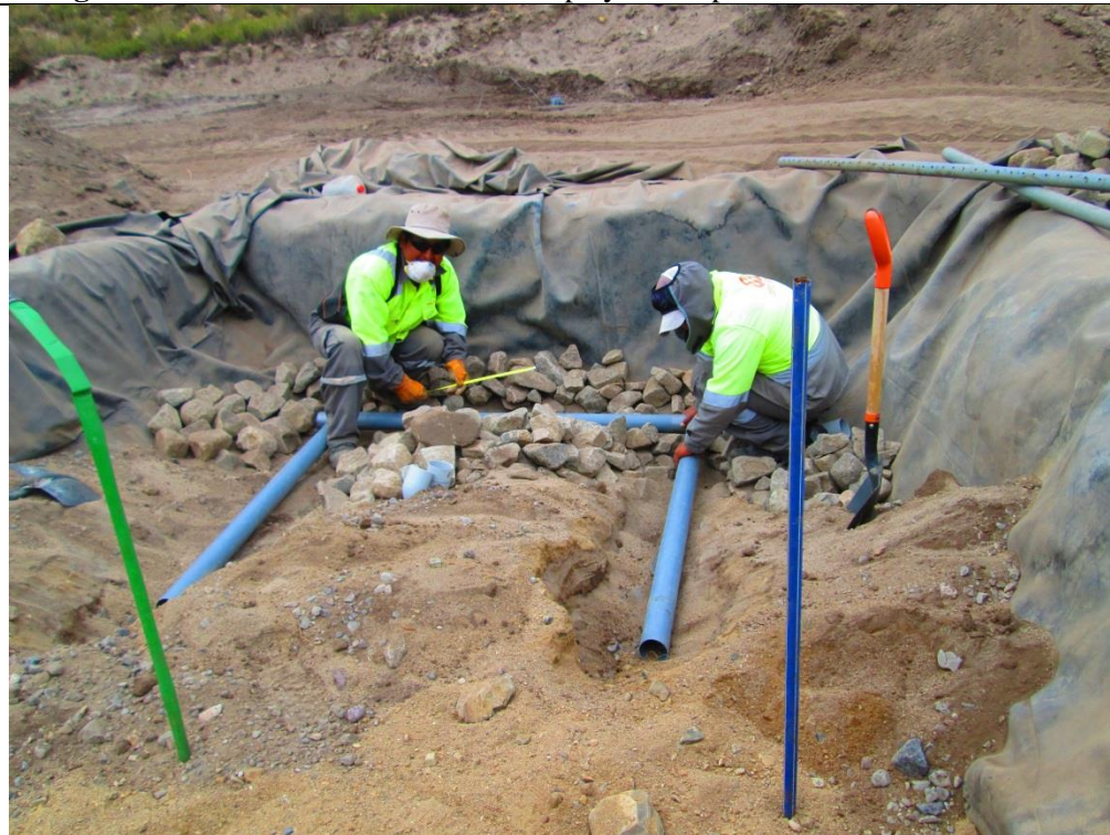
Fotografía N° 15: Colocación de la tubería de drenaje o salida de ARD.
