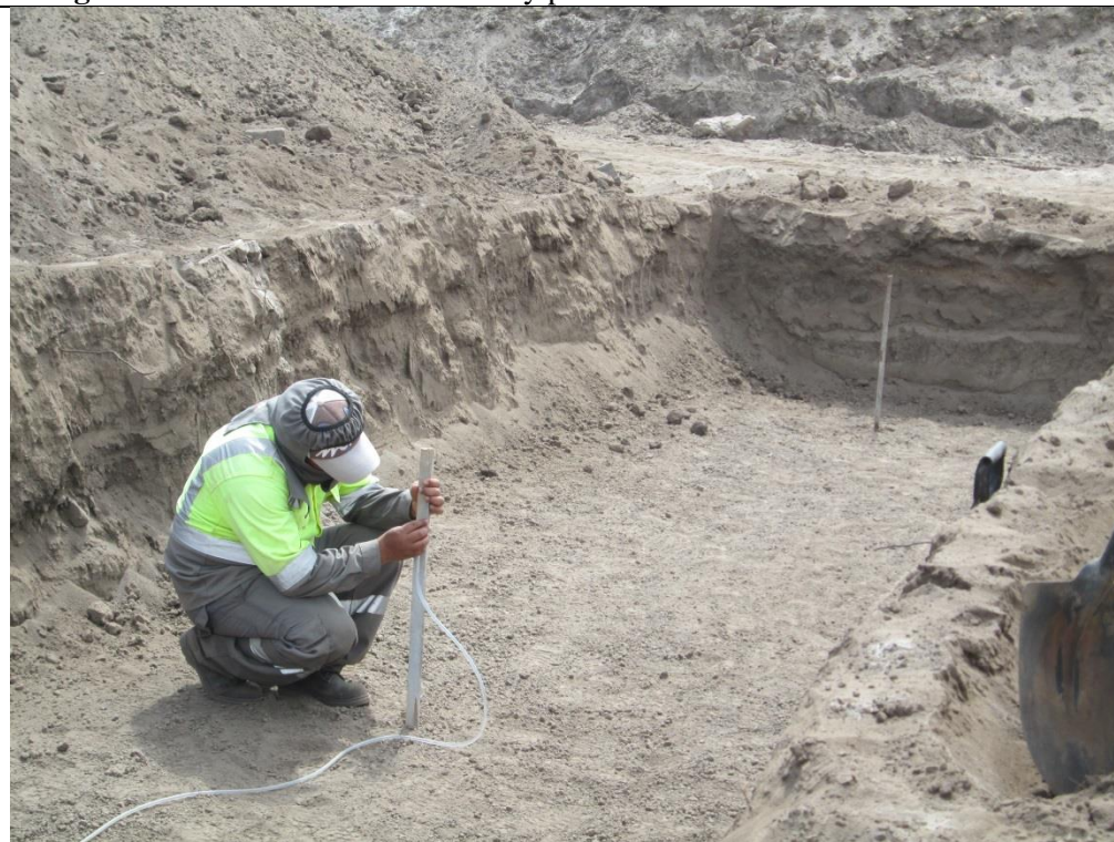
Fotografía N° 12: Nivelación de la base a 5% de pendiente.
