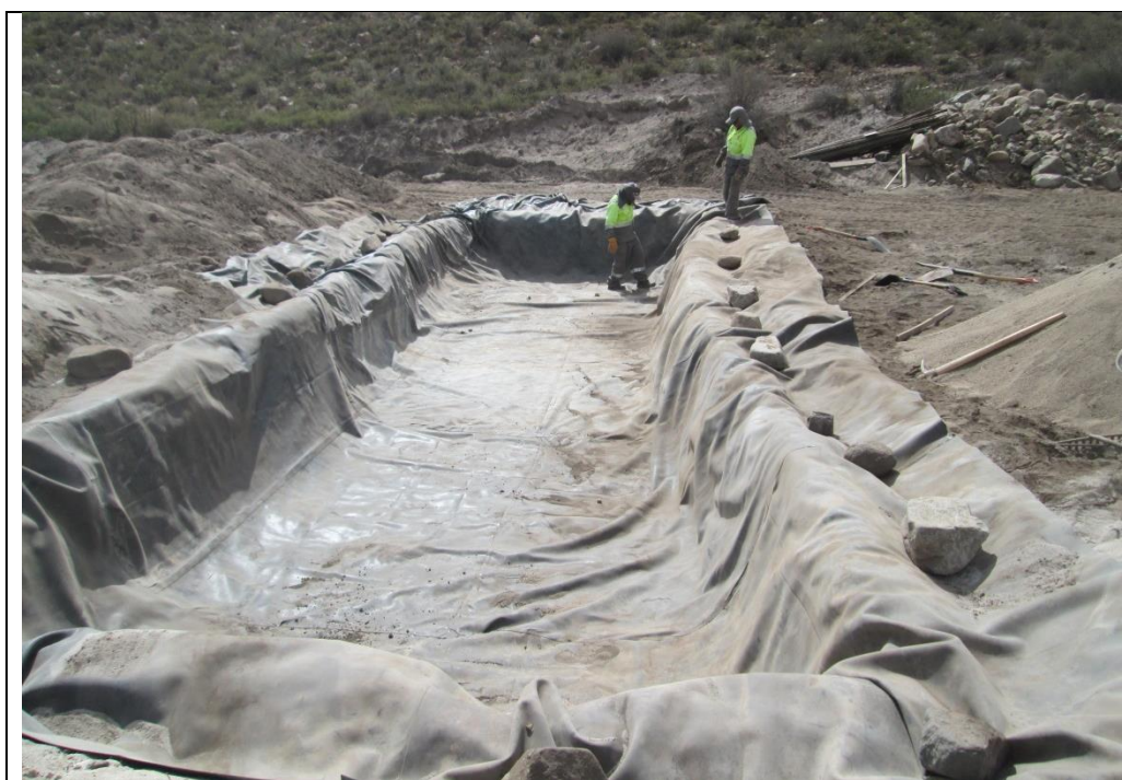
Fotografía N° 13: Colocación de geomembrana en el lecho del humedal artificial
