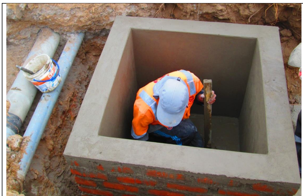
Fotografía N° 4: Construcción de trampas de grasa.
