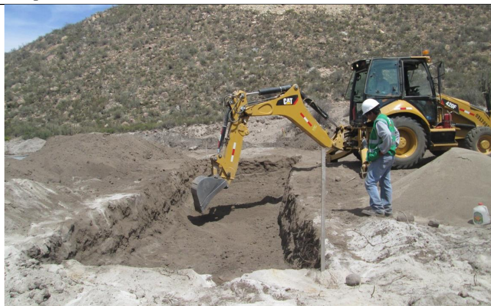
Fotografía N° 10: Excavación del lecho del humedal artificial.
