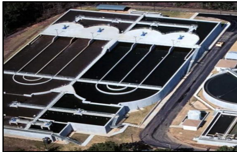
FIGURA 2 - VISTA DE UNA PTAR MODALIDAD ZANJAS DE OXIDACIÓN
