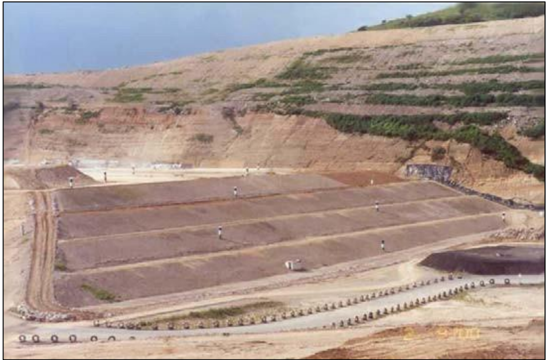
Figura N° 4: Relleno sanitario de alta densidad con cobertura
