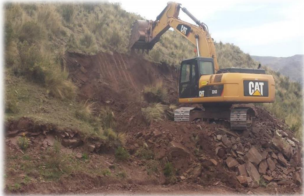
Fotografía N° 21: Soterrado de los residuos sólidos dispuestos, en el área nueva de disposición final
