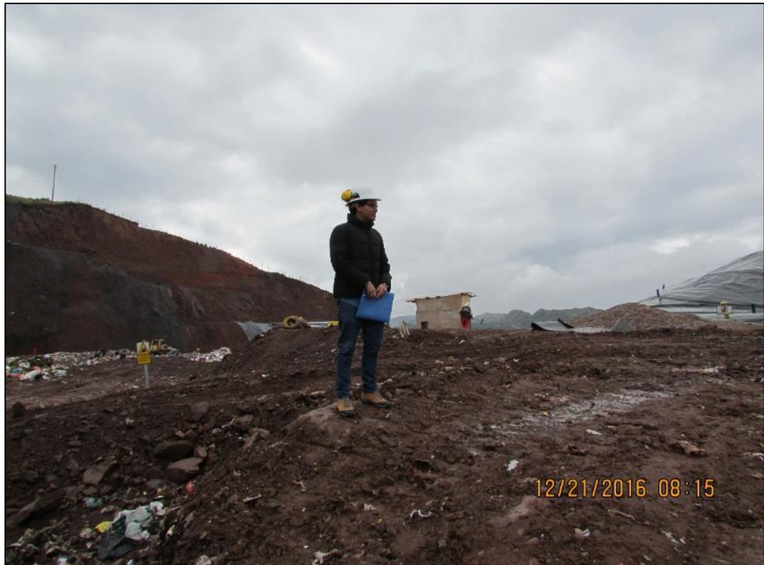
Fotografía N° 2: Inspección de las instalaciones del botadero de Haquira
