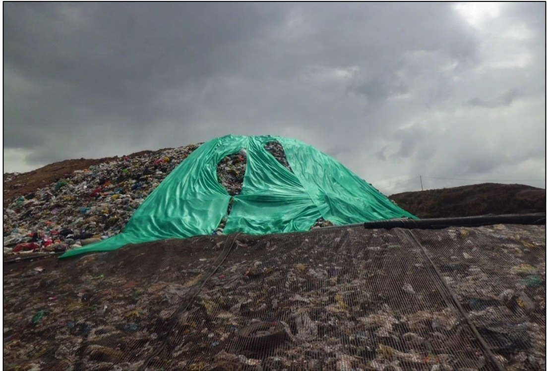
Fotografía N° 5: Acumulación de los residuos sólidos en el botadero de Haqira, sin considerar las pautas para una adecuada cobertura final
