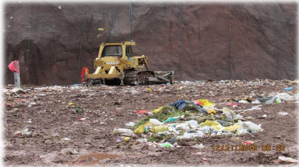
Fotografía N° 18: Compactación de los residuos dispuestos en el botadero
