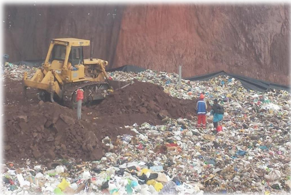
Fotografía N° 21: Soterrado de los residuos sólidos dispuestos, en el área nueva de disposición final
