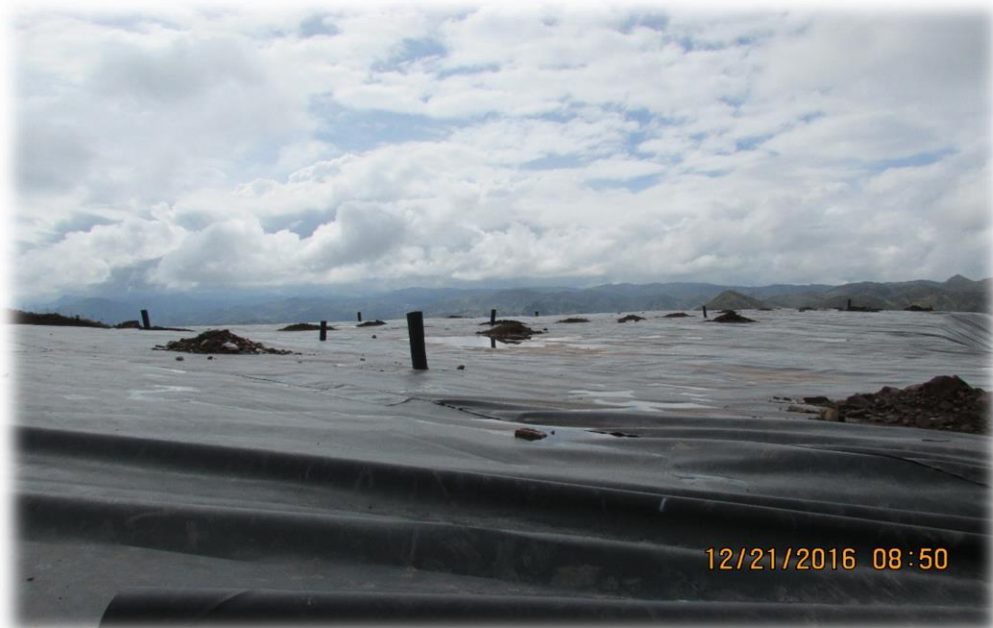
Fotografía N° 25: Chimeneas instaladas en el área de disposición de residuos existente
