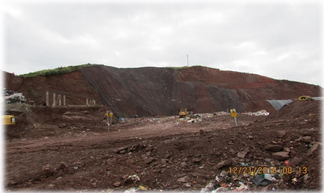
Fotografía N° 15: Botadero de Haqira, sin la presencia de caminos internos
