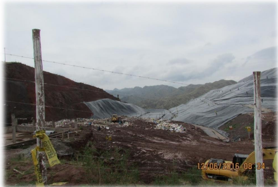
Fotografía N° 14: Cerco perimétrico instalado en la parte frontal del botadero
