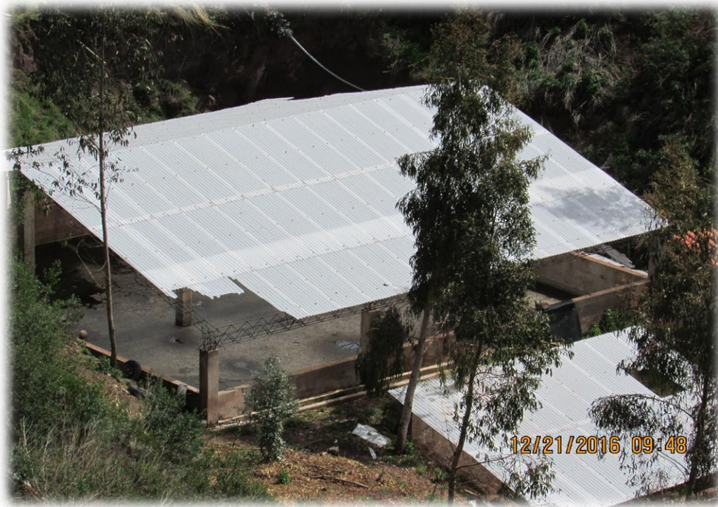
Fotografía N° 23: Pozo de reserva de lixiviados habilitados
