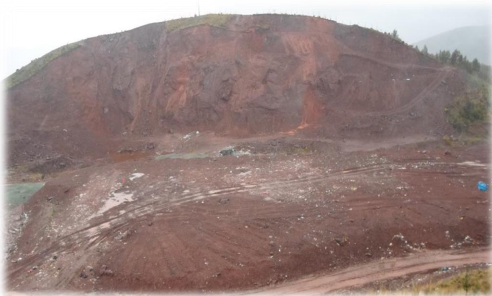
Fotografía N° 19: Corte del talud para fines de soterramiento actual
