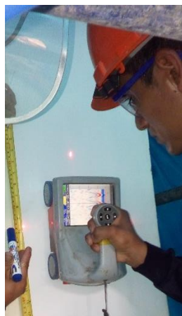
Fotografía N°55. Escaneo preliminar en columna para extracción del Sótano – Casa Matriz.
