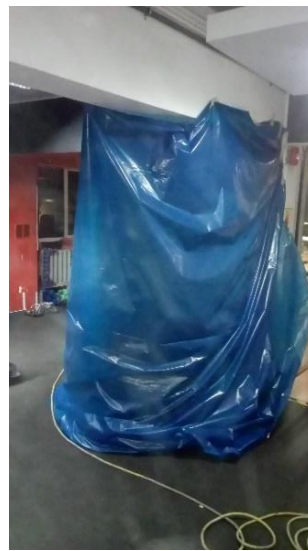
Fotografía N°20. Encapsulado para picado puntual en columna del 2° Nivel – Gimnasio.
