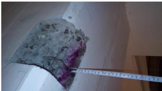
Fotografía N°39. Prueba de carbonatación en columna de 3° nivel – Casa Matriz.
