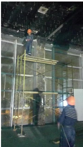
Fotografía N°53. Extracción de muestra en losa del 4° nivel – Torre Medica.
