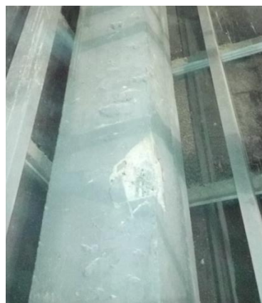
Fotografía N°18. Escaneo preliminar en columna de 4° Nivel-Torre Medica.
