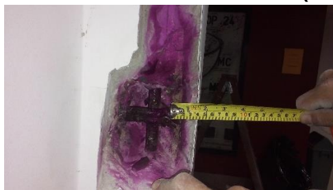
Fotografía N°43. Prueba de carbonatación en columna de 2° nivel - Euroidiomas.
