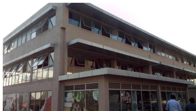
Fotografía N°3. Vista Panorámica de Edificio "Gimnasio".
