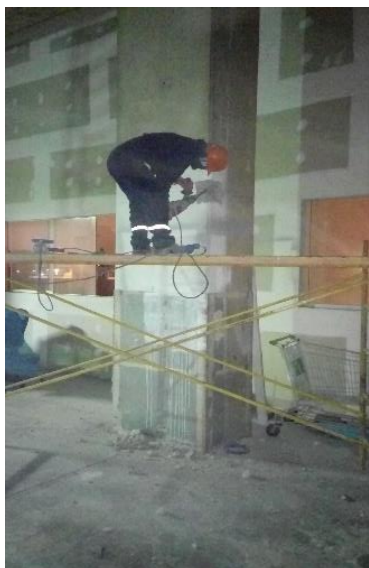
Fotografía N°47. Extracción de muestra en columna del 2° nivel – Casa Matriz.
