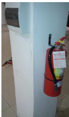
Fotografía N°10. Agrietamiento con espesor mayor a 1cm en columna del 1° Nivel - Euroidiomas.
