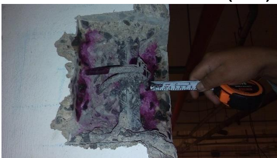
Fotografía N°23. Medición del recubrimiento en columna del 3° Piso – Casa Matriz.
