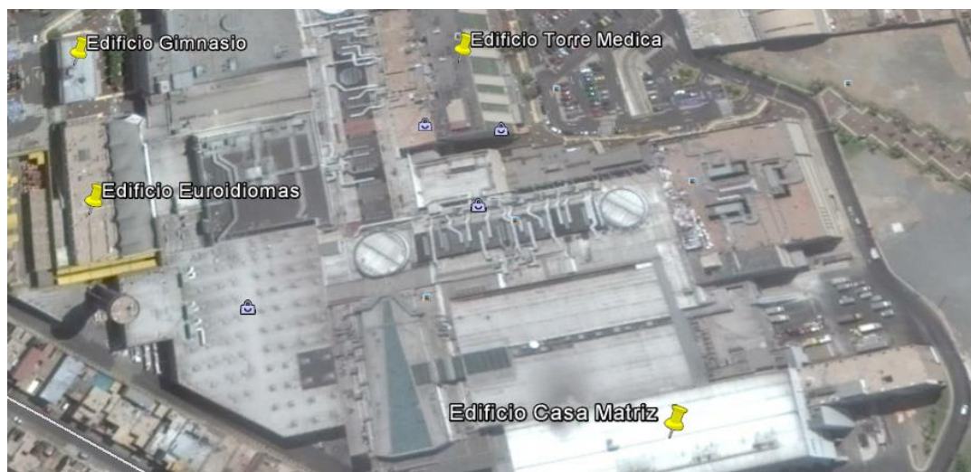
Fotografía N°1. Ubicación de los 04 edificios a inspeccionar -Mall Bellavista.
