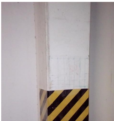
Fotografía N°15. Escaneo preliminar en columna de Sótano- Casa Matriz.
