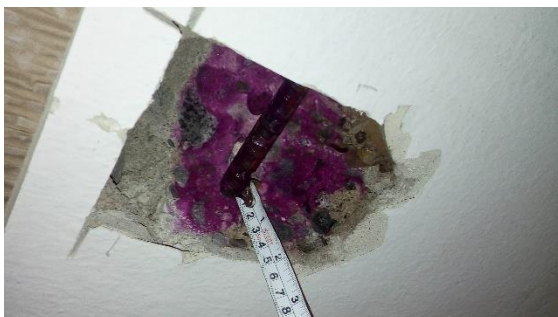
Fotografía N°27. Medición del recubrimiento en losa del 1° Piso - Euroidiomas.
