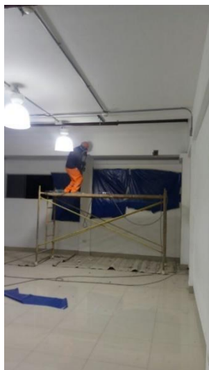
Fotografía N°21. Picado puntual en parte central de viga del 2° Nivel - Euroidiomas.
