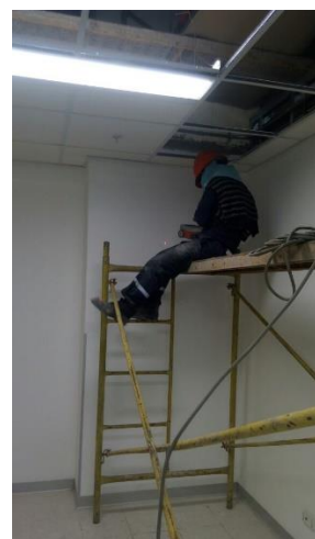
Fotografía N°58. Escaneo preliminar en columna para extracción del 2° Piso – Torre Medica.
