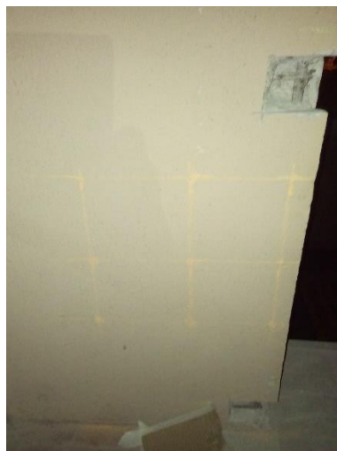
Fotografía N°16. Escaneo preliminar en viga de Fachada – Gimnasio.
