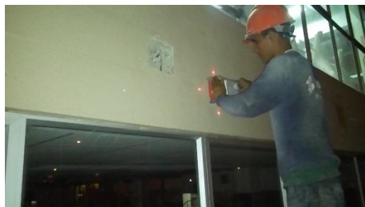
Fotografía N°56. Escaneo preliminar en viga para extracción del 1° Piso - Gimnasio.
