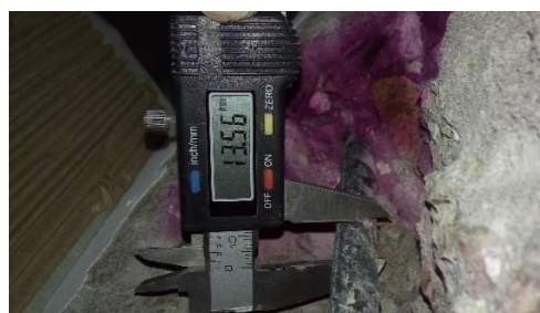
Fotografía N°32. Calibración del acero longitudinal en columna de 1° Piso – Gimnasio.
