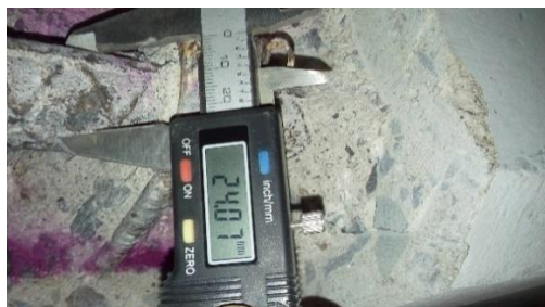
Fotografía N°31. Calibración del acero longitudinal en columna de Sótano – Casa Matriz.
