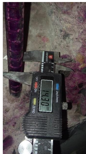
Fotografía N°34. Calibración del acero longitudinal en losa de 3° Piso – Torre Medica.
