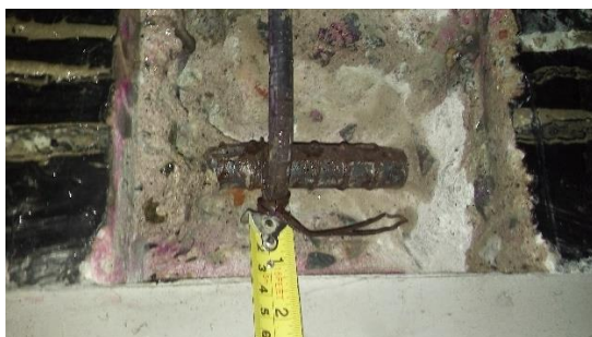
Fotografía N°29. Medición del recubrimiento en viga del 4° Piso - Torre Medica.
