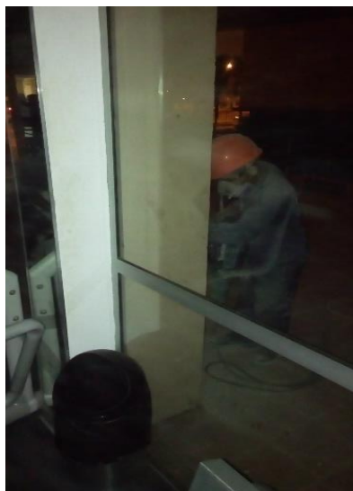
Fotografía N°49. Extracción de muestra en columna del 2° nivel – Gimnasio.
