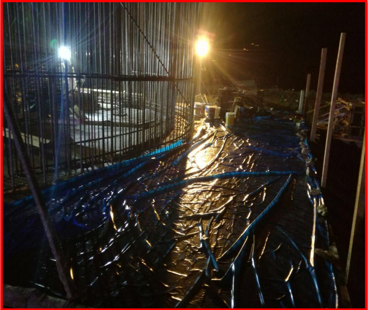
Foto 9: Colocación de plástico curado con z membrana- silo. Fuente: Propia.
