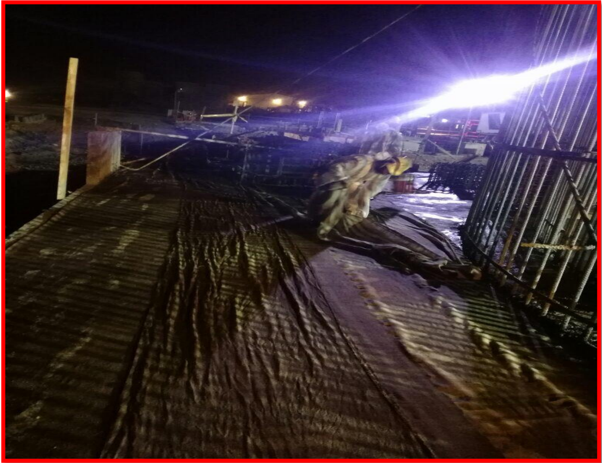
Foto 8: Colocación de yute húmedo curado - silo. Fuente: Propia.
