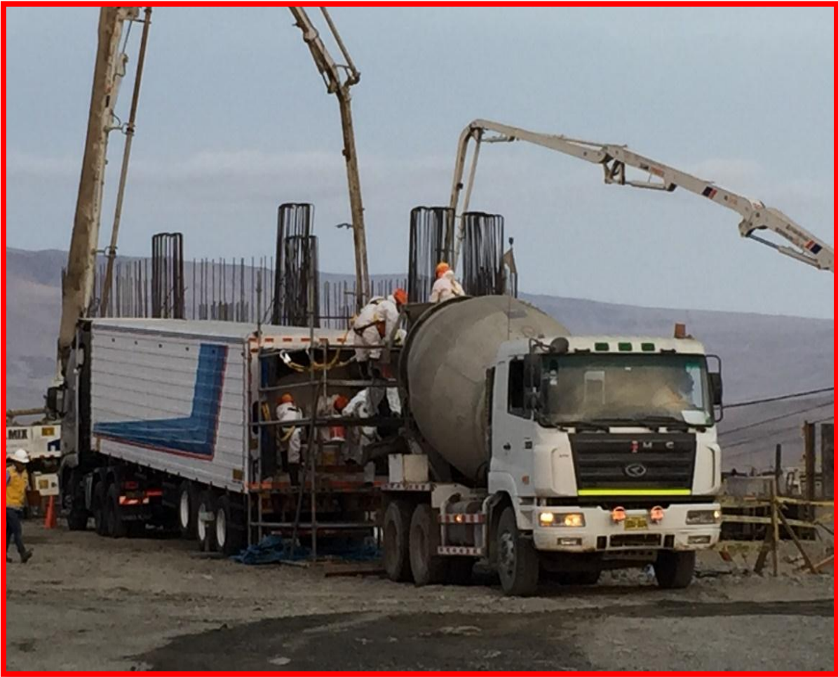
Foto 3: Colocación de hielo en mixer. Fuente: Propia.
