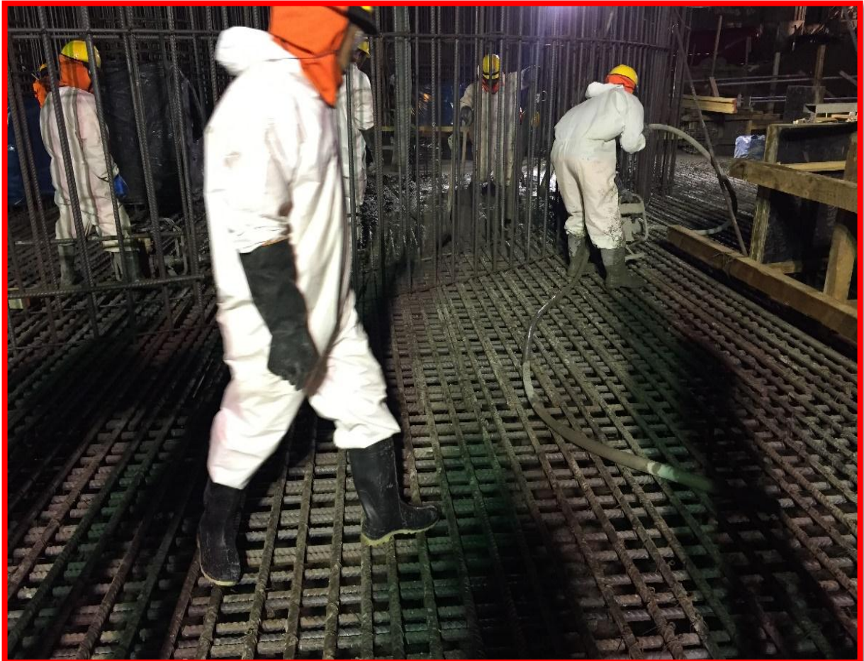
Foto 7: vibrado de concreto – silo. Fuente: Propia.
