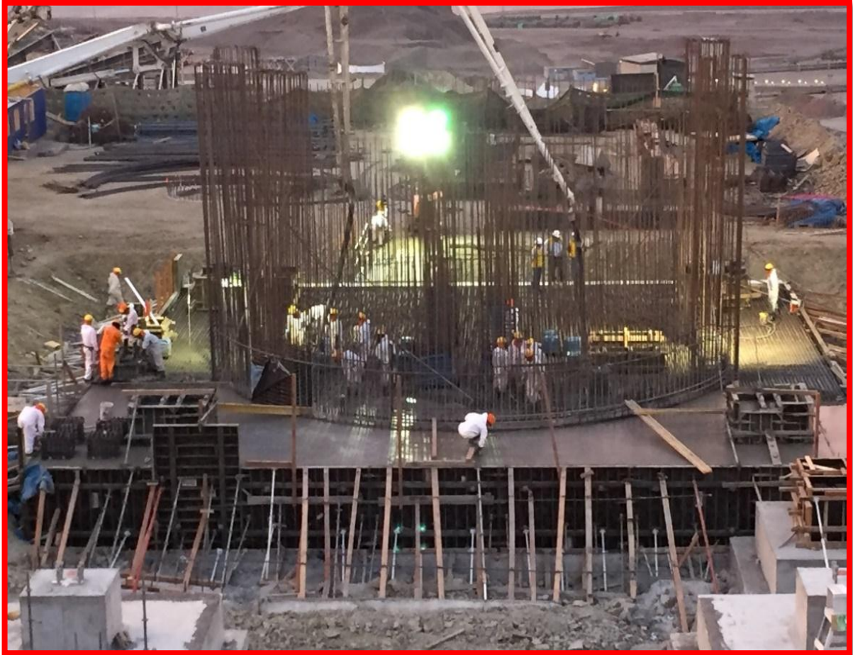
Foto 5: Vaciado masivo con 2 bombas (2 plantas) silo. Fuente: Propia.
