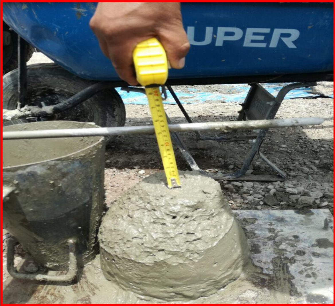
Foto 12: Slump pf4 - para vaciado masivo 5". Fuente: Propia.
