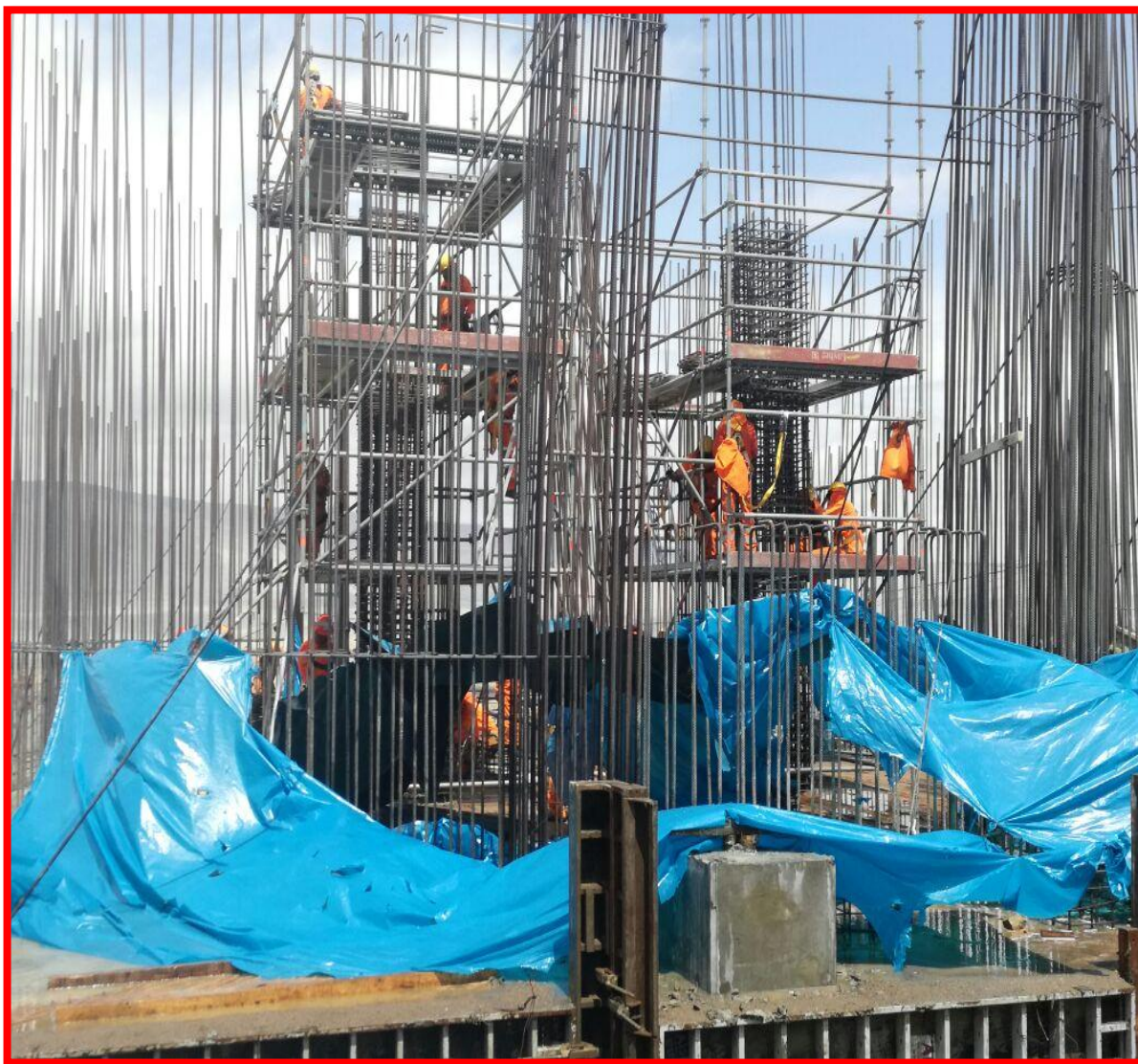
Foto 15: Trabajos posteriores de colocación de acero. Fuente: Propia.
