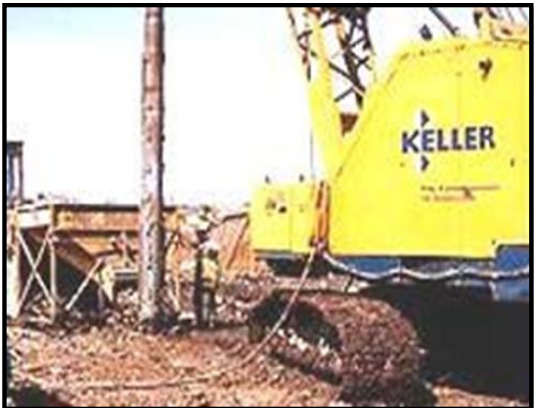
Equipo requerido para los trabajos.
