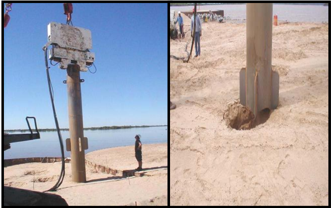
Equipo para trabajos de vibrocompactación.
