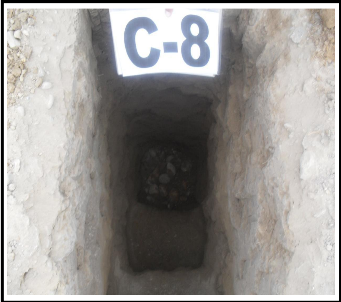
Vista Interior de la Calicata (C-8), Se Puede Apreciar en las Paredes y Fondo de la Excavación el Subsuelo Constituido por Limo con Arena (ML) y Grava Pobremente Graduada con Arena y Cantos (GP), Respectivamente. Fuente: Propia.
