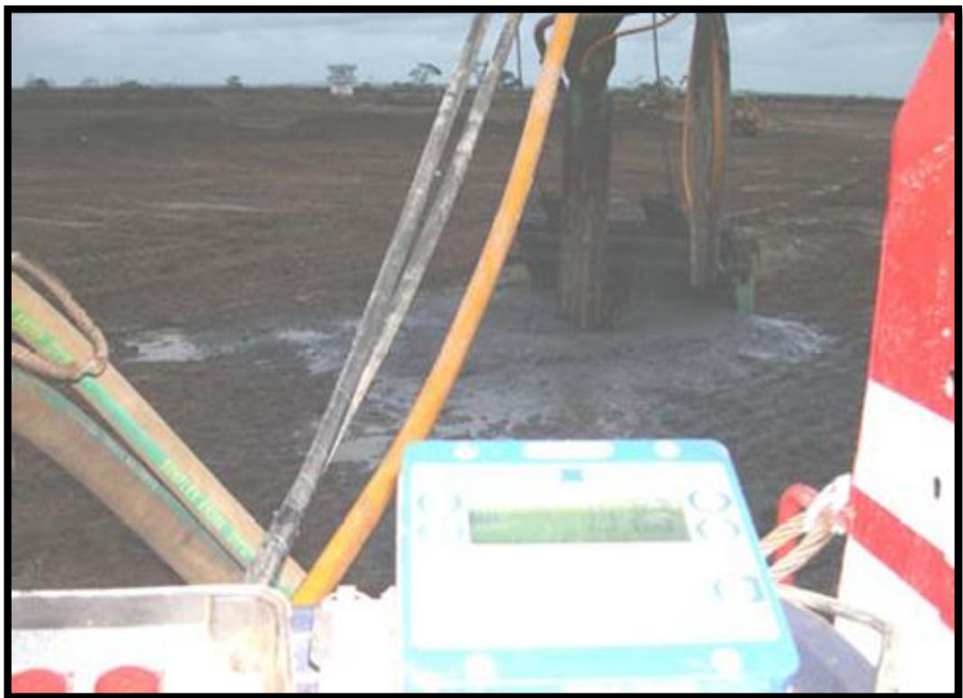
Monitoreo de los trabajos de vibroflotación.
