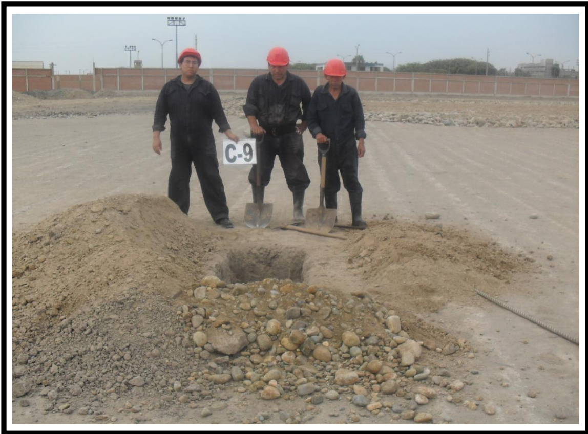
Vista Exterior de la Calicata (C-9), Se Puede Apreciar el Material Excavado Constituido por Limo con Arena (ML) y Grava Pobrementemente Graduada con Arena y Cantos (GP). Fuente: Propia.
