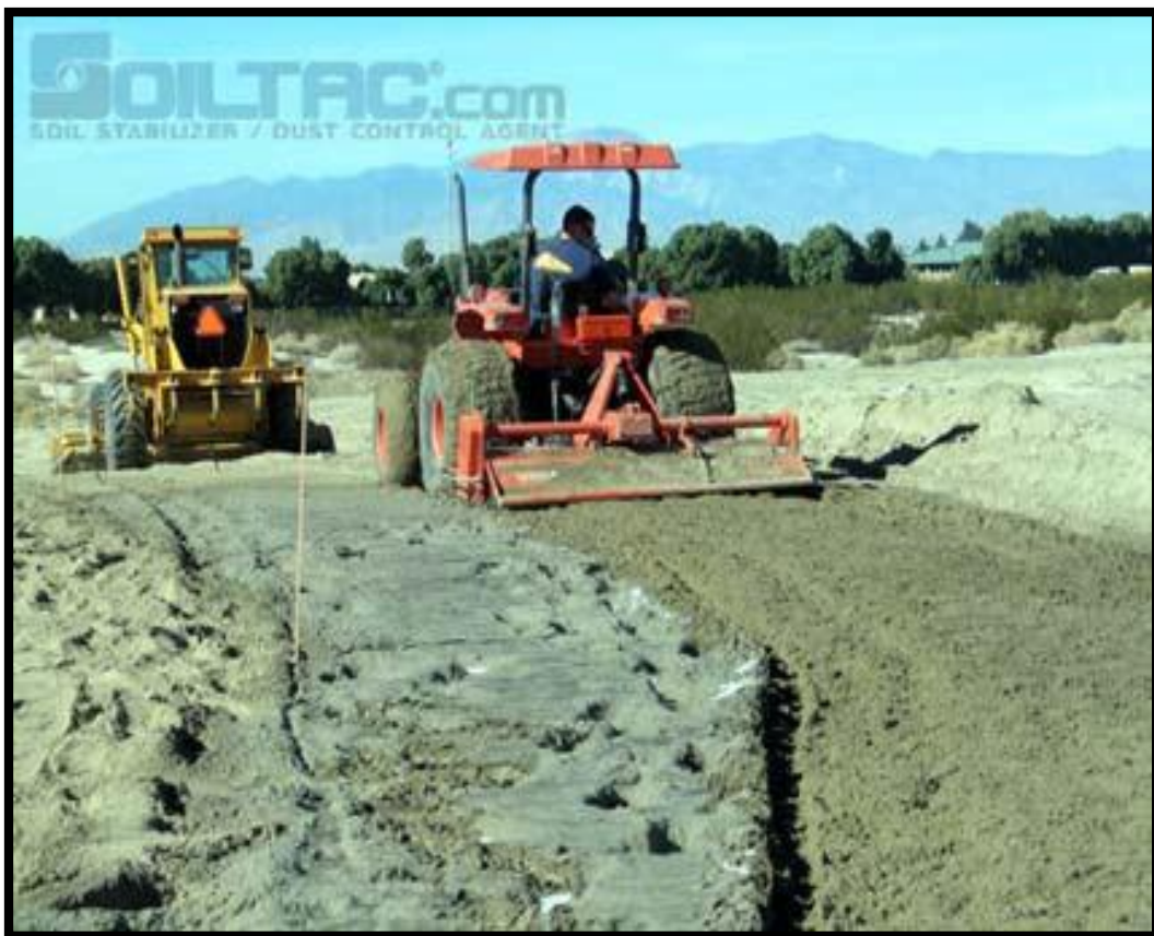
Aplicación del Suelo – Cemento con escarificador.
