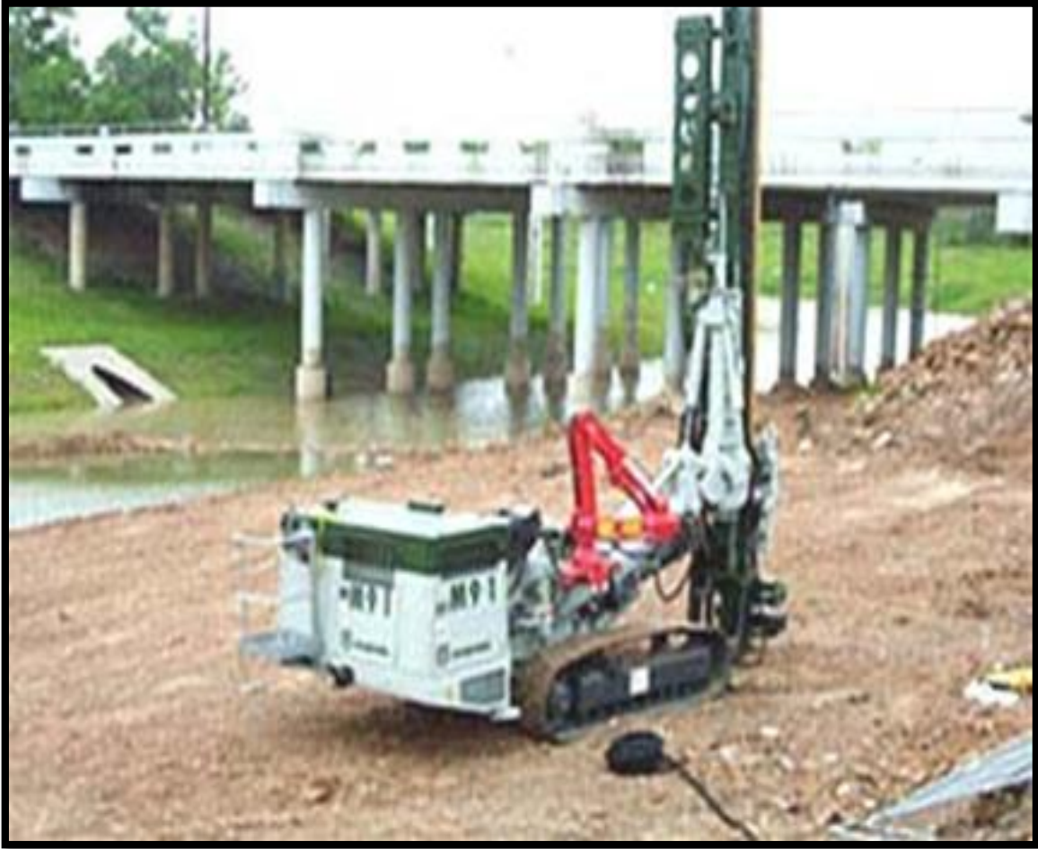
Empleo de Jet Grouting.
