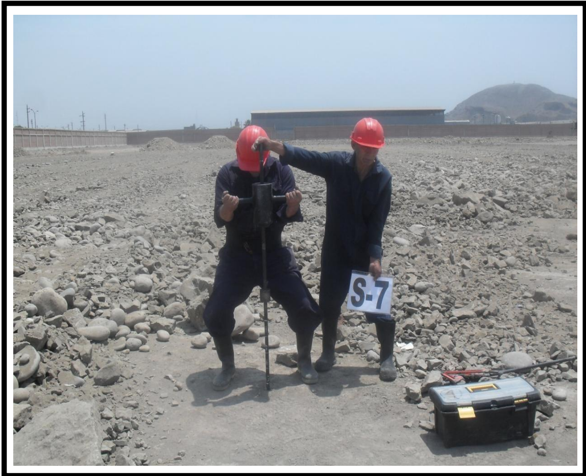
Vista Mostrando el Sondaje (S-7) Realizado con Equipo de Penetración Dinámico (Cono de Peck). Fuente: Propia.
