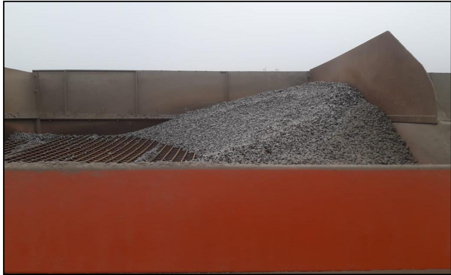
Se aprecia la Grava Chancada en la tolva de la planta de asfalto. Fuente: Propia.
