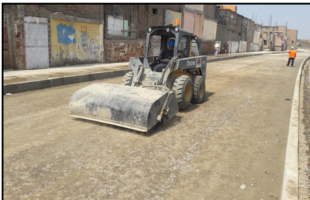
Limpieza con barredora mecánica sobre una base granular, para luego proceder a imprimir y finalmente colocar la capa de carpeta asfáltica. Fuente: Propia.
