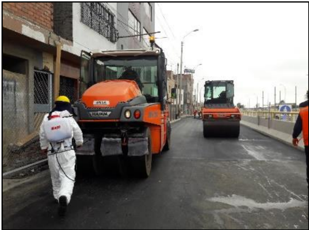
Rodillo compactador Tandem Vibratorio (liso) HD 90, es el primer rodillo que pasa apenas la mezcla asfáltica es esparcida. Fuente: Propia.
