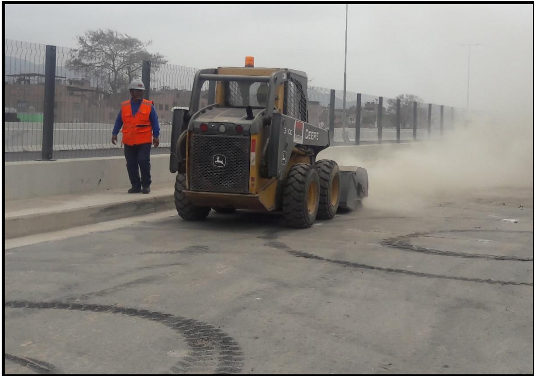
Limpieza con barredora mecánica sobre una capa asfáltica existente, para aplicar luego el riego de liga y finalmente colocar la segunda capa de carpeta asfáltica. Fuente: Propia.
