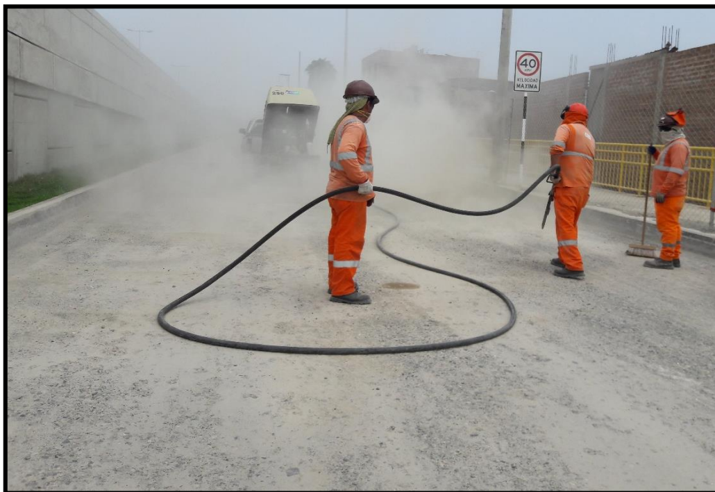
Limpieza con compresora mecánica para retirar todo el material suelto y fino de la base a imprimir. Fuente: Propia.
