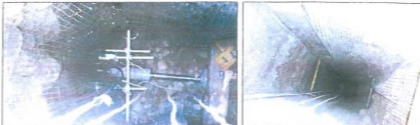
Figura 4.5 – Equipo posicionado a la profundidad de 9.0m en la calicata C-03 listo para el ensayo.
