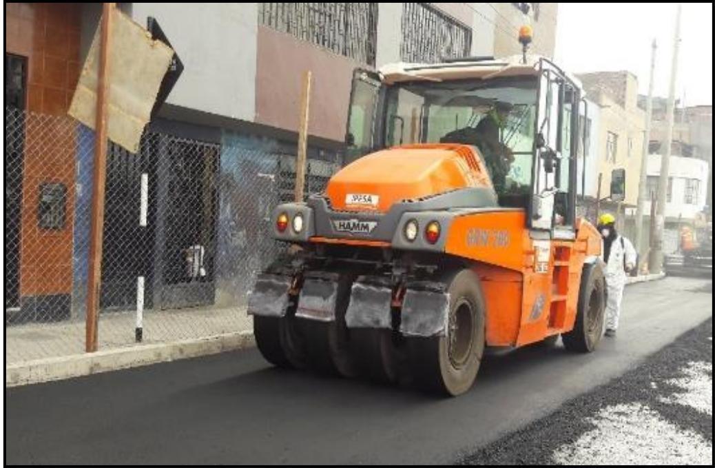
Rodillo compactador Tandem Vibratorio (liso) HD 90, es el primer rodillo que pasa apenas la mezcla asfáltica es esparcida. Fuente: Propia.
