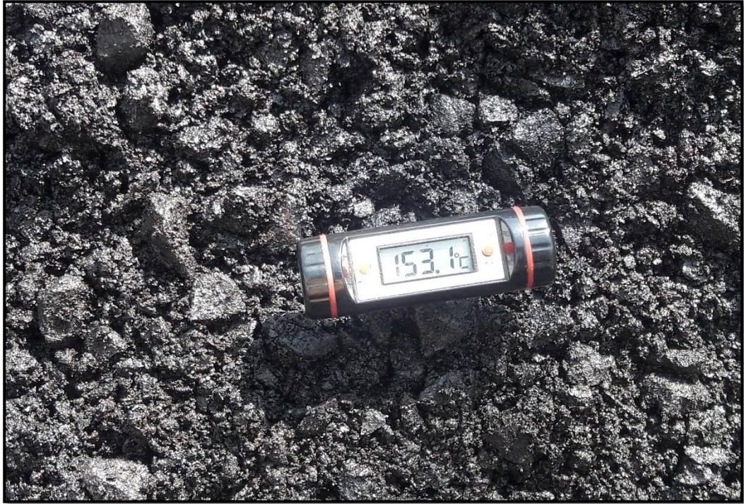
Temperatura de la mezcla asfáltica. Fuente: Propia.
