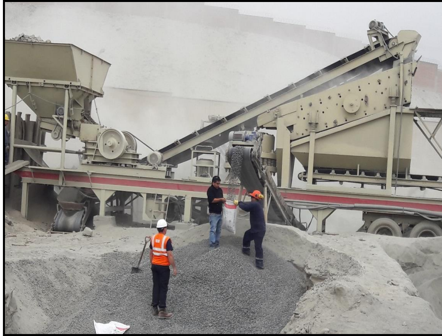
Extracción de muestra de nuestros agregados, contamos con una chancadora tipo VSI las cuales garantiza la calidad de nuestros agregados. Fuente: Propia.
