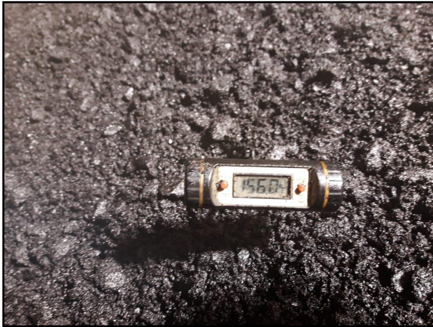
Control de Temperatura de la mezcla asfáltica. Fuente: Propia.
