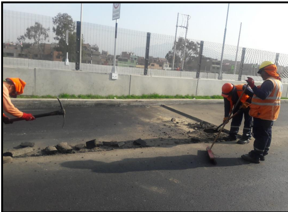
Retiro del material producto del corte realizado para tener un correcto empalme. Fuente: Propia.
