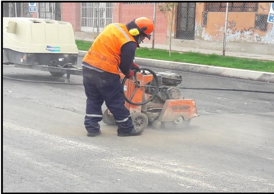
Corte longitudinal y transversal de los bordes donde se empalmará la carpeta asfáltica nueva, el corte se realiza para un correcto empalme y/o unión de la capa existente con la nueva. Fuente: Propia.
