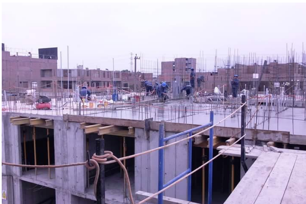
Imagen No 10: Construcción de Estructuras Bloque D, del Proyecto Conjunto Residencial Los Huertos. Fuente: De Documentación de Oficina Técnica de Obra.
