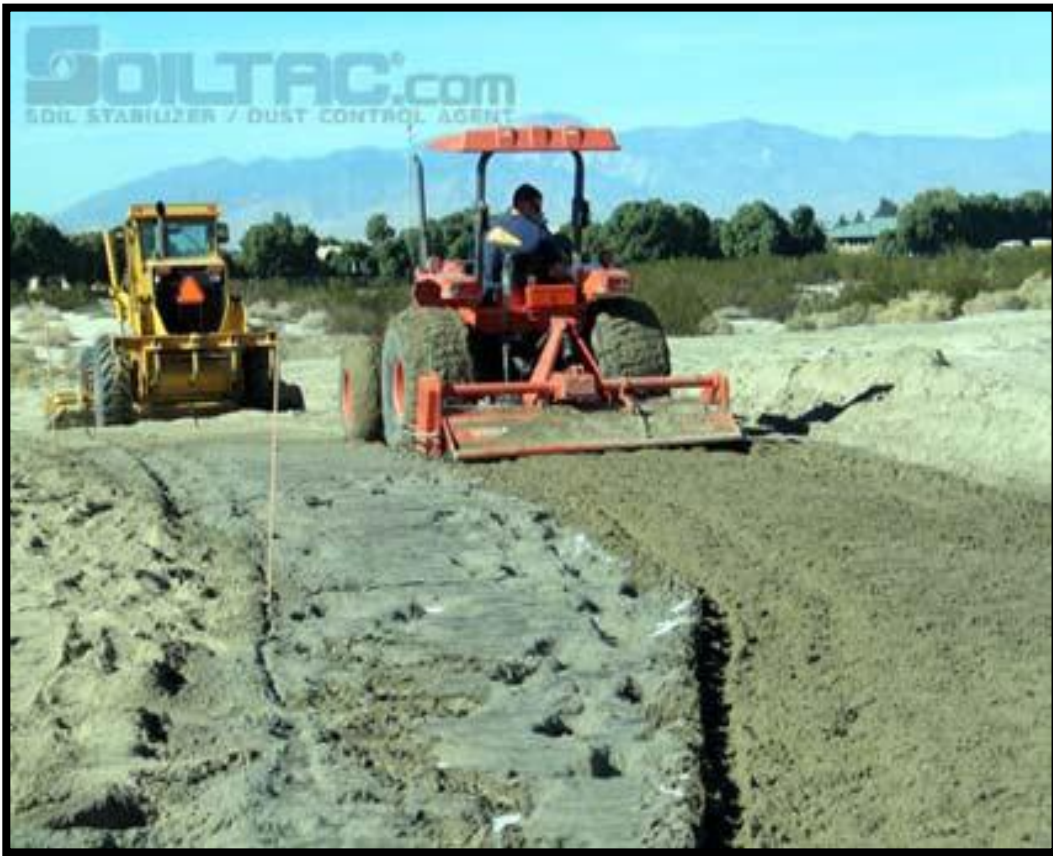
Aplicación del Suelo – Cemento con escarificador.
