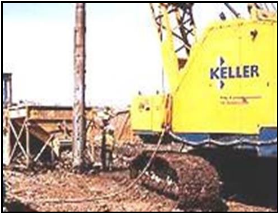
Equipo requerido para los trabajos.
