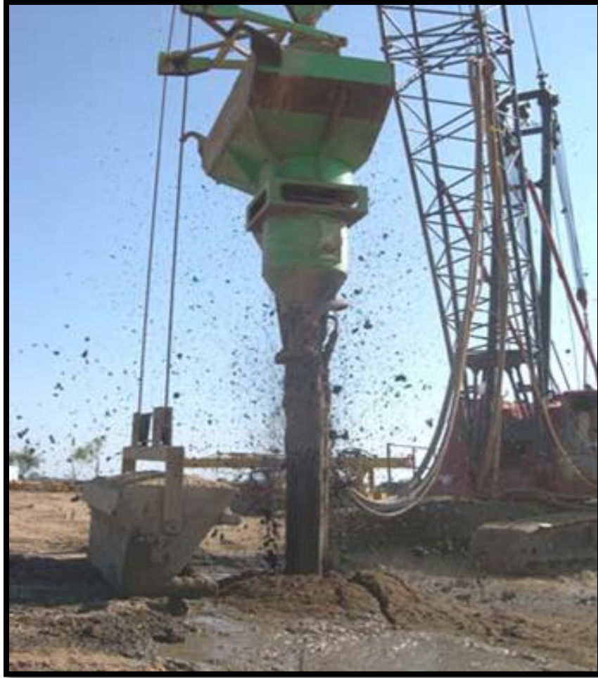
Equipo de vibroflotación. Fuente: SOILTAC SOIL PERÚ S.A.C.
