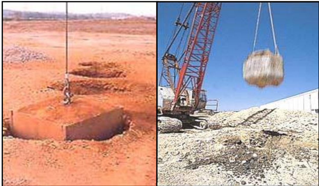
Trabajos de compactación dinámica. Fuente: GBC Cimentaciones. México.
