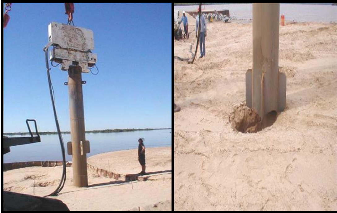
Equipo para trabajos de vibrocompactación.
