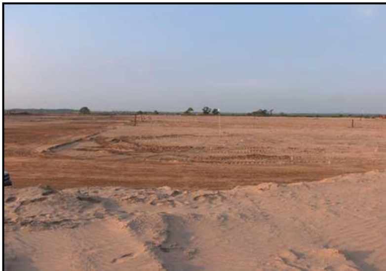
Terraplenes de carga. Fuente: SOILTAC SOIL PERÚ S.A.C.
