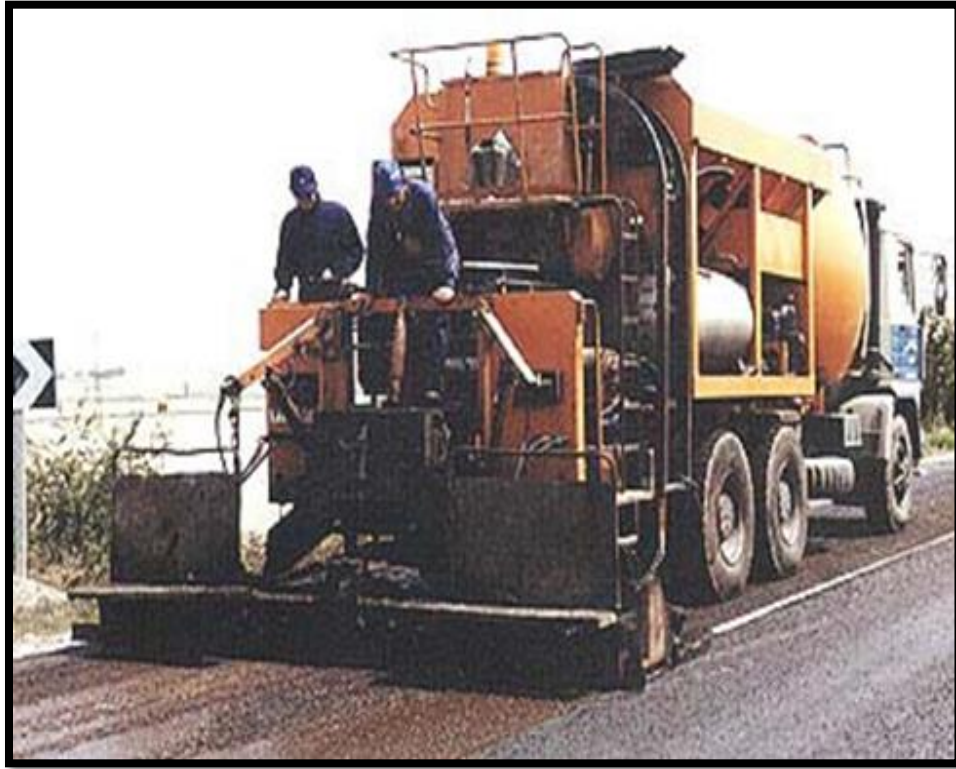
Estabilización del suelo con asfalto. Fuente: SOILTAC SOIL PERÚ S.A.C.
