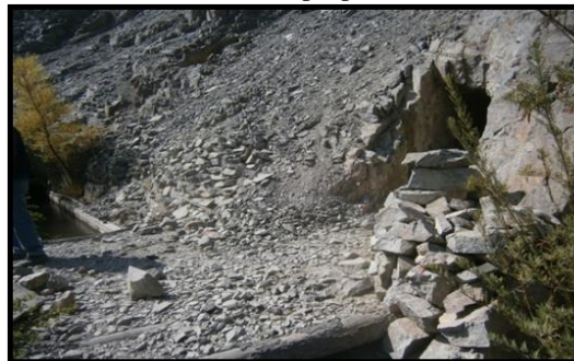
Fotografía N°06: Plataforma PMA Walter Gamero Rosas Fuente propia
