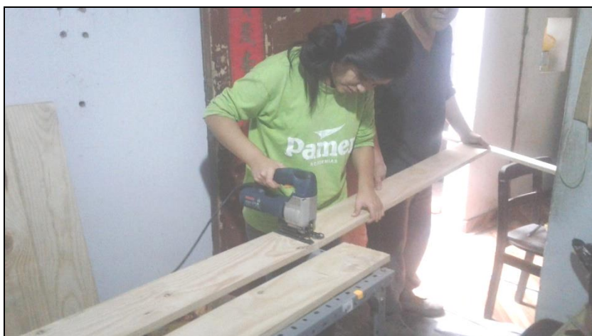
Figura 17. Construcción de andamio para bioensayo.
