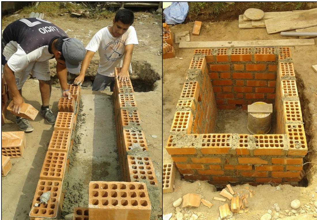
Fotografía N° 4. Construcción de canal de desbaste (Izq.) y tanque séptico (Der.)
