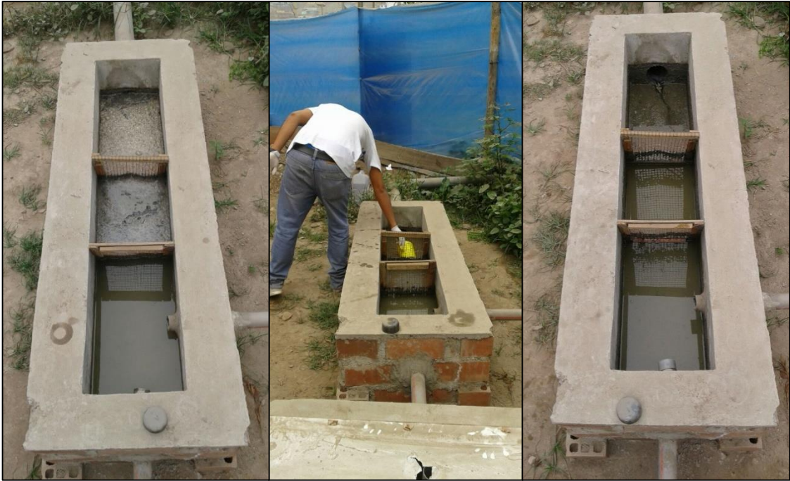
Fotografía N° 12. Limpieza del canal de desbaste
