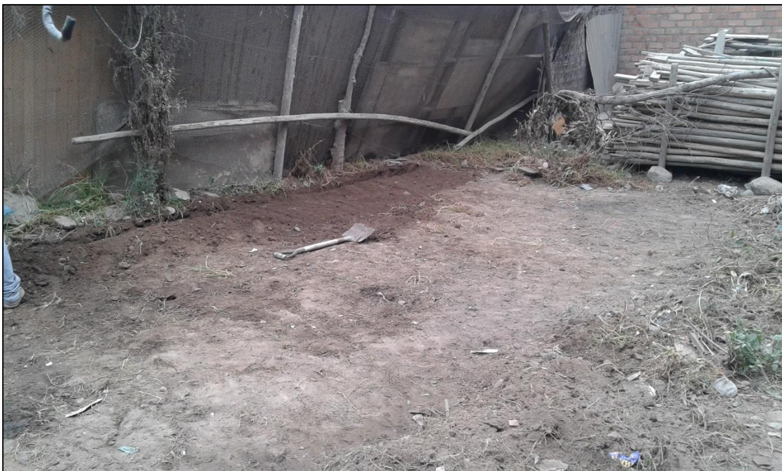
Fotografía N° 2. Terreno nivelado y deshierbar
