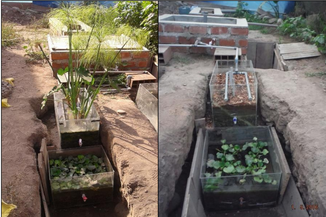
Fotografía N° 10. Sistema de Biofiltro SB1 (Izq.) y Sistema de Biofiltro SB2 (Der.)
