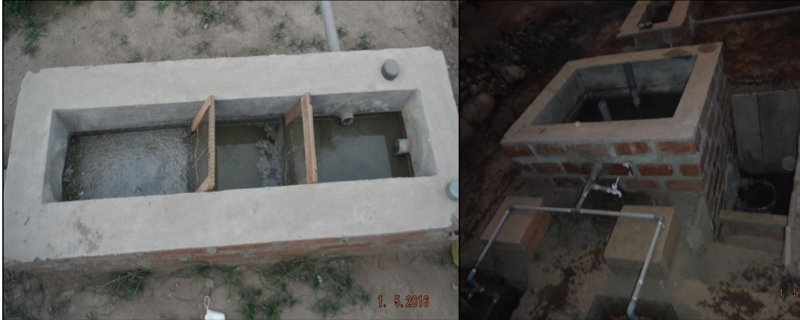
Fotografía N° 6. Instalación de rejas gruesas y finas e instalación de tuberías
