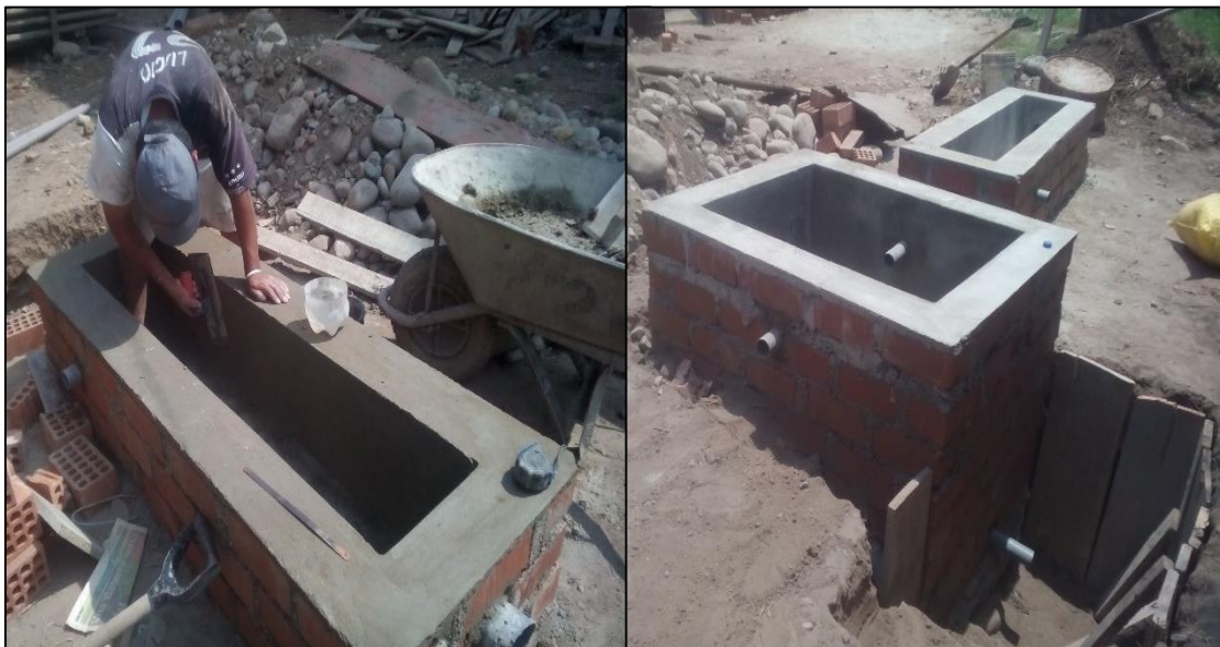
Fotografía N° 5. Tarrajado del canal de desbaste y tanque séptico
