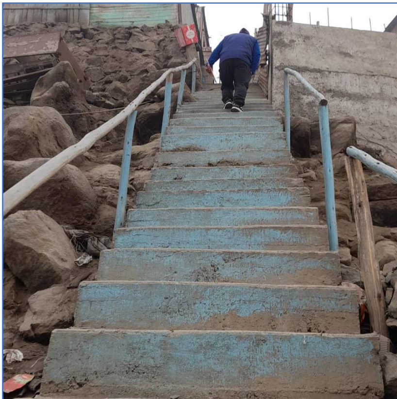
Imagen 04 Escaleras construidas sin asesoramiento técnico (Pasaje 4)
