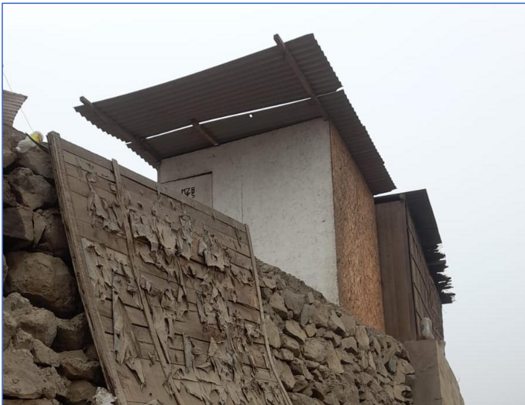
Imagen 06 Techos de material precario, con mala instalación
