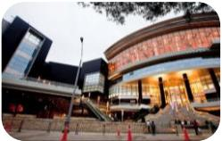
Real Plaza Salaverry (Lima)     | Estructura aporticada de concreto armado; losas aligeradas; refuerzos metálicos en áreas específicas. | Arquitectura contemporánea comercial.                                 | Concreto armado, acero, vidrio templado.                        | Diseño funcional con énfasis en circulaciones amplias; uso de acero y vidrio en fachadas para aportar transparencia y luz; estructura pensada para alta afluencia peatonal.   |
