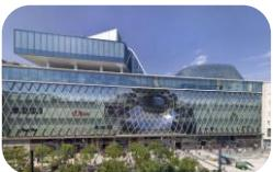
MyZeil (Frankfurt)               | Estructura mixta de acero y concreto; cubierta espacial de acero y vidrio.                            | Arquitectura paramétrica, con envolvente orgánica y geometría fluida. | Acero estructural, vidrio laminado, concreto armado.            | Destaca por su cubierta de vidrio en forma de "embudo" que genera un efecto dinámico y alta iluminación natural; diseño orientado a experiencia sensorial y estética icónica. |
