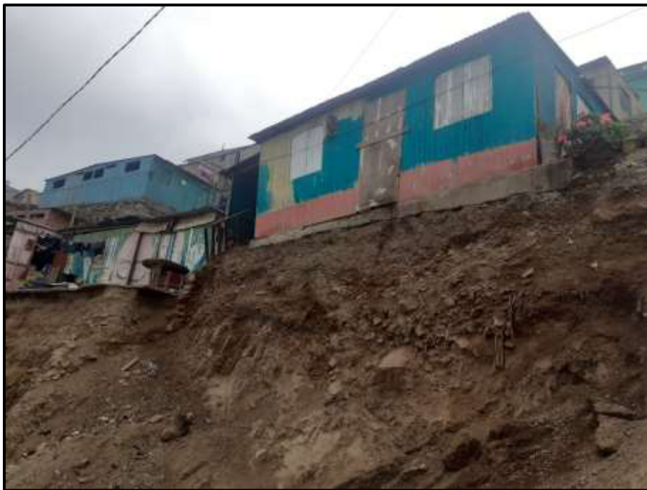
Viviendas ubicadas sobre taludes inestables con material de relleno, sin muros de contención, expuestos a un movimiento sísmico.
