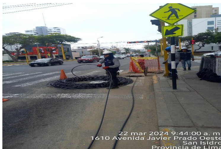
Despliegue de F.O por canalizado.
