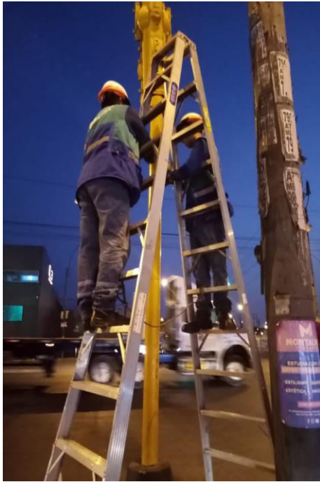
Fotografía 10: Instalación del Portatubo en la Av. Argentina con Universitaria
