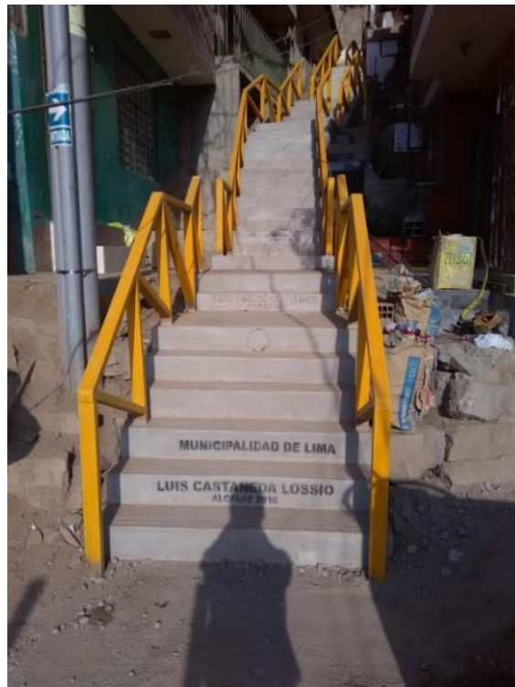
Escalera terminada – Pasaje Tarapacá
