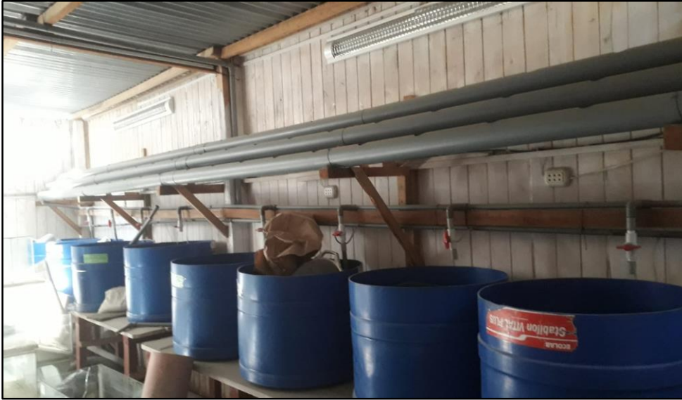
Figura 26: foto de la construcción del sistema de recirculación del agua. Fuente: Autoría propia
