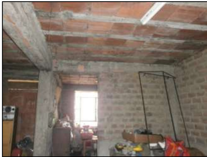
Figura 8: Elementos de concreto armado, de f'_c = 175 \text{ Kg/cm}^2 .
