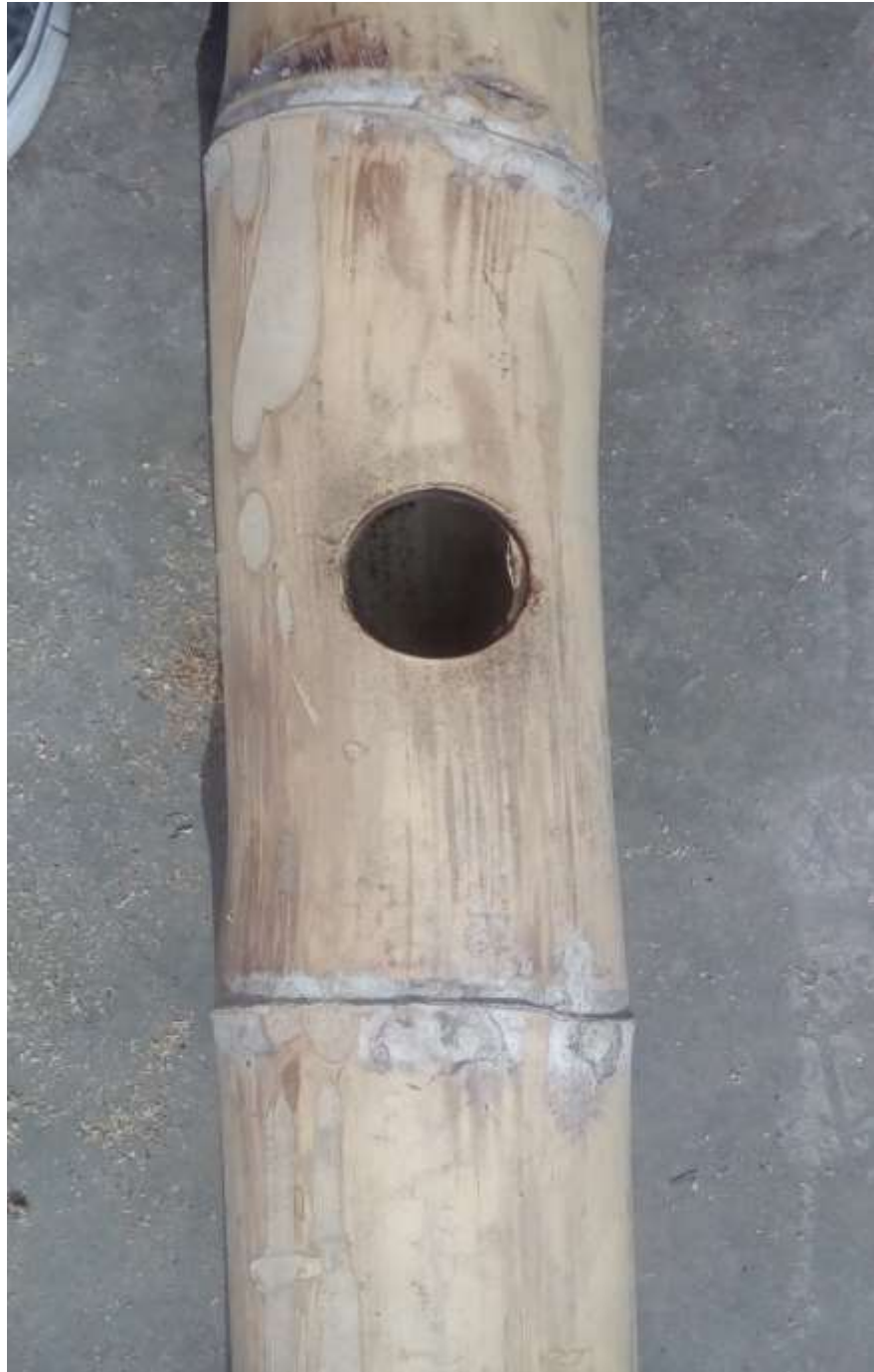
Fig.27 –Bambú con perforación de entre cayos Fuente: Propia.
