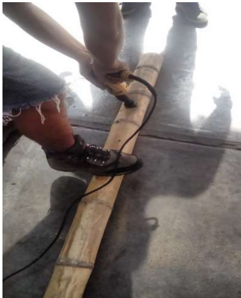
Fig.26 – Perforación de 2” entre cayos del bambú para el posterior ingreso del concreto Fuente: Propia
