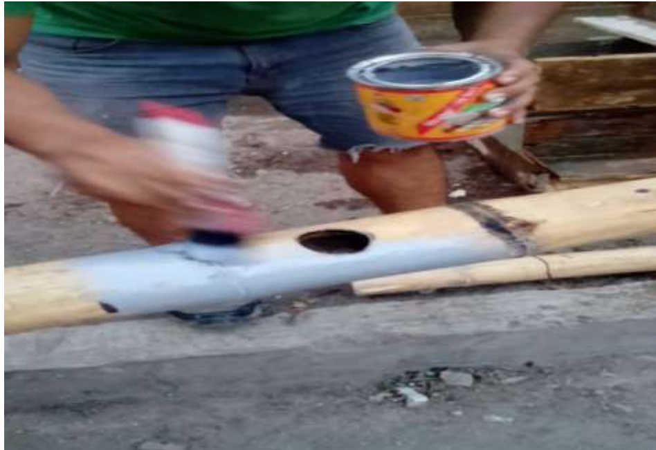
Fig.29 –Colocación de Adhesivo Epóxico en el bambú para dejar secar 5 minutos por especificación a fin de lograr mayor adherencia Fuente: Propia
