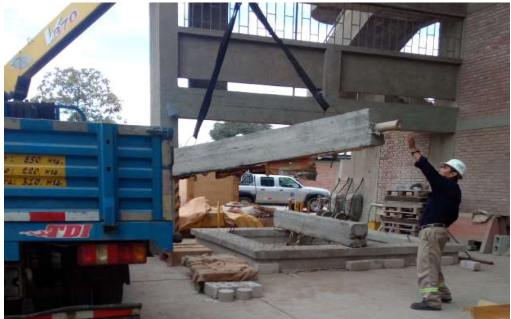
Fig.38 –Se dejó la viga en el laboratorio de Estructuras Antisísmicas de la PUCP para su registro y posterior programación de Ensayo Fuente: Propia
