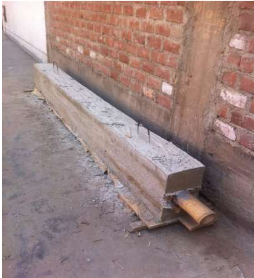
Fig.36 –Viga 0.25x0.50x3.50 m con refuerzo de Bambú de la especie Guadua Angustifolia Fuente: Propia
