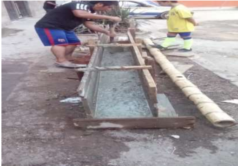
Fig.33 –Solado en la base de encofrado Fuente: Propia
