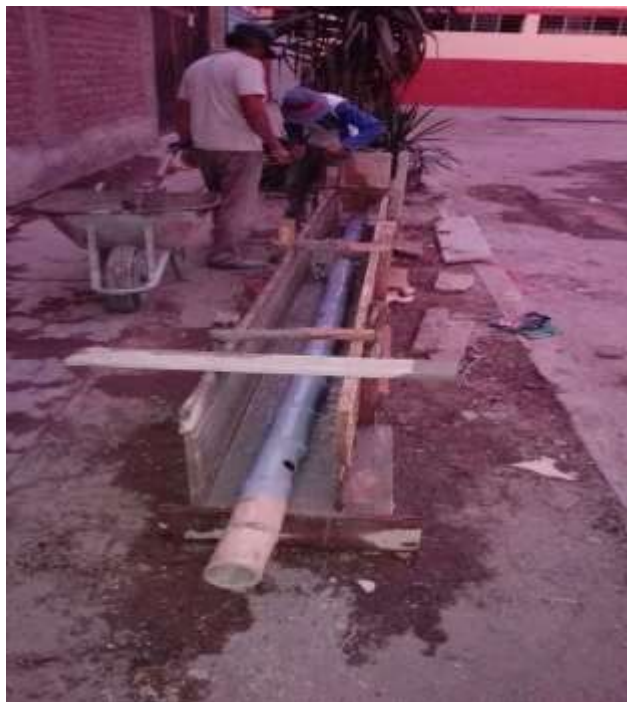
Fig.34 –Colocación del refuerzo de bambú en el encofrado de viga Fuente: Propia
