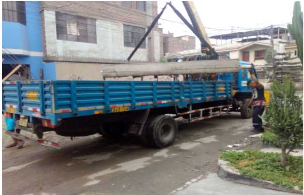
Fig.37 –Se dispuso de un vehículo - grúa para poder transportar las vigas al laboratorio para su posterior ensayo Fuente: Propia
