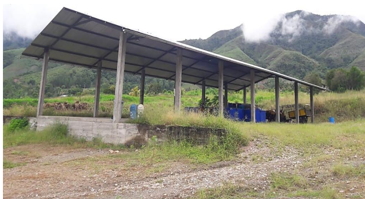
Figura 5. Sala de procesamiento primario inadecuado de Silver Corporation SAC.
