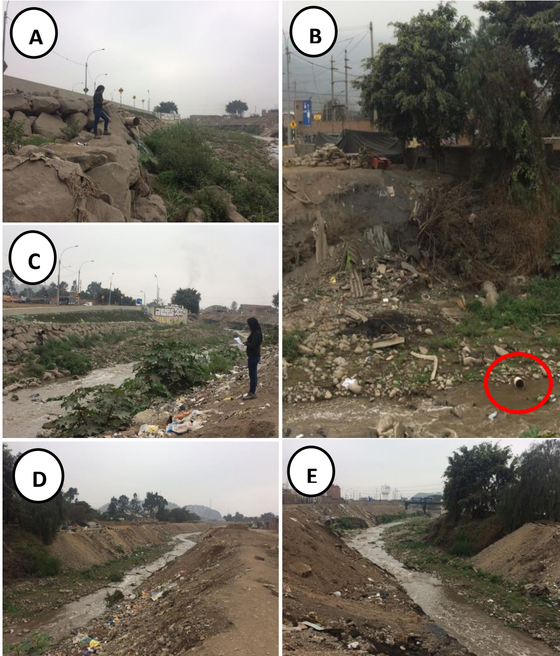
Figura 7. Estación PMA – 04. (A) En dirección de Oeste a Este, cruzando la Panamericana Norte, se observa una tubería que vierte sus aguas residuales al río Chillón. (B) Se observa desmontes, residuos de construcción y una tubería que vierte las aguas residuales domiciliarias de las viviendas que se encuentran en la ribera del río Chillón. (C), (D) y (E) En las figuras se observan residuos sólidos domiciliarios que fueron arrojados posiblemente por las poblaciones aledañas o terceros; además de restos de la quema de residuos sólidos.
