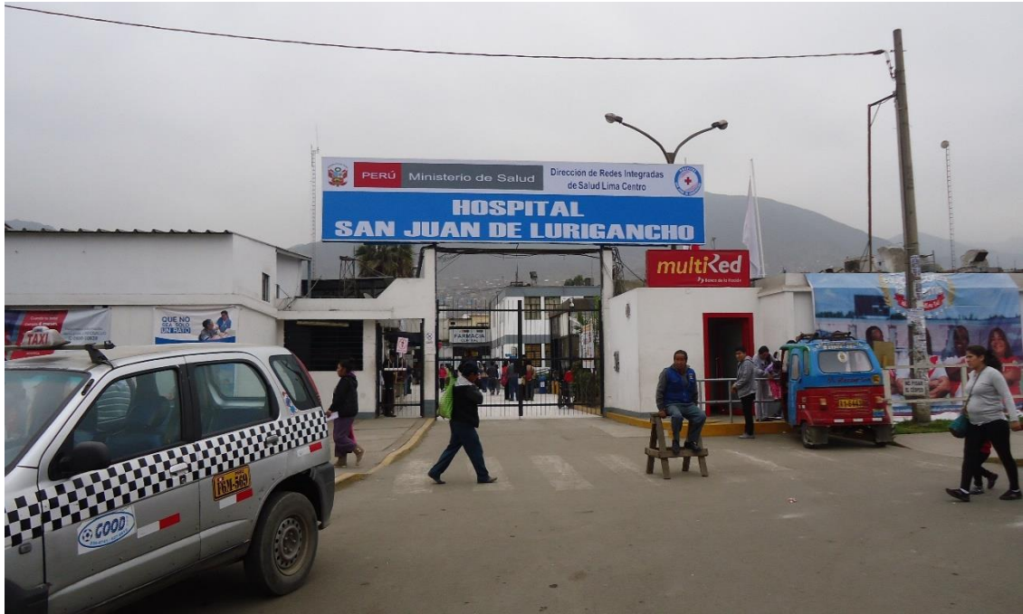
Hospital San Juan de Lurigancho (Entrada y Puerta Principal)
