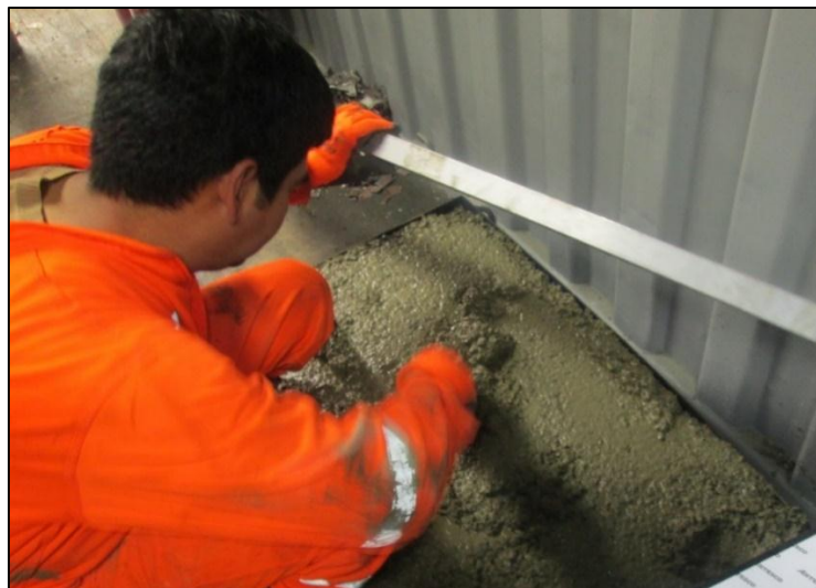
Fotografía N° 4; Acabado de concreto.
