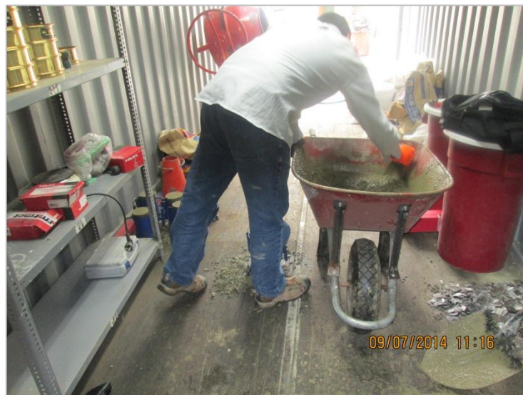
Fotografía 8; Muestreo del concreto.
