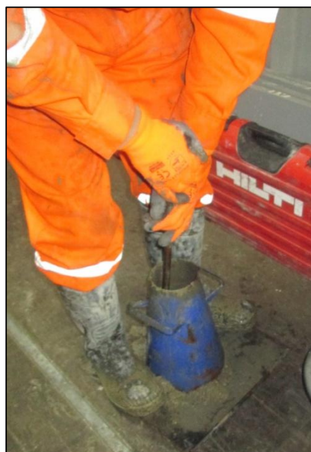
Fotografía6; Medición de slump
