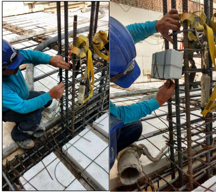
Fotografía N° 8; Colocación del sensor.
