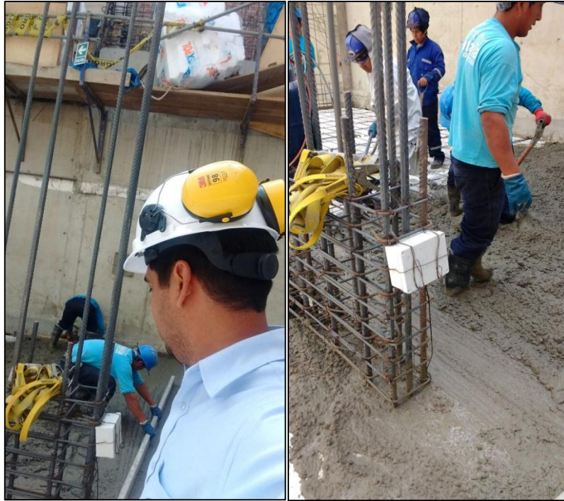
Fotografía N° 12; Vaciado del concreto.
