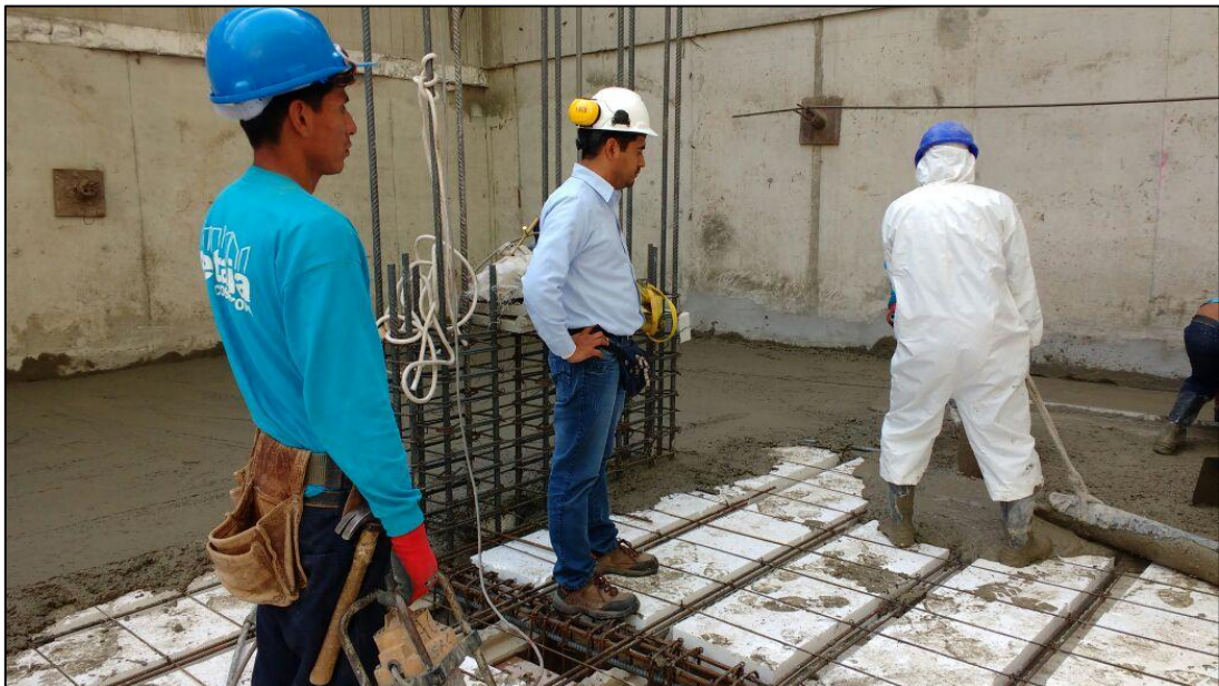
Fotografía N° 11; Vaciado del concreto.
