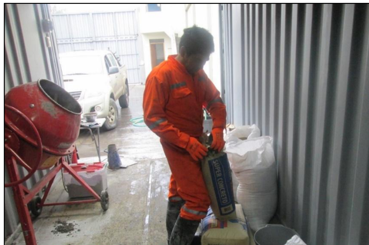
Fotografía N° 2; Elaboración del concreto.
