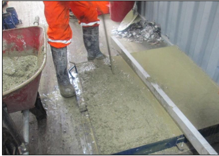
Fotografía N° 6; Acabado del concreto.
