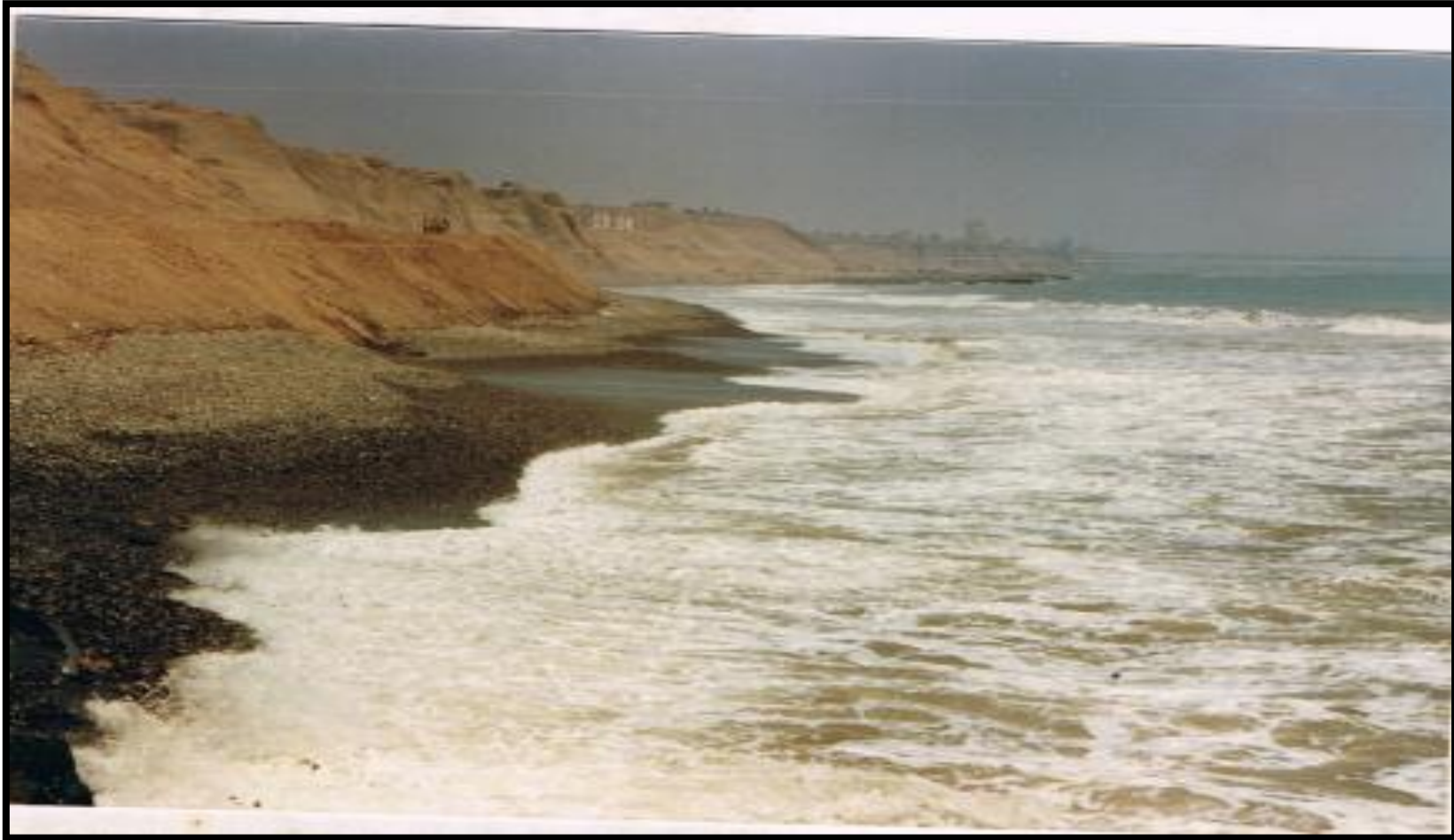
Foto 11: Tramo E2-E3 visto desde el espigón E3. Fuente: Propia.
