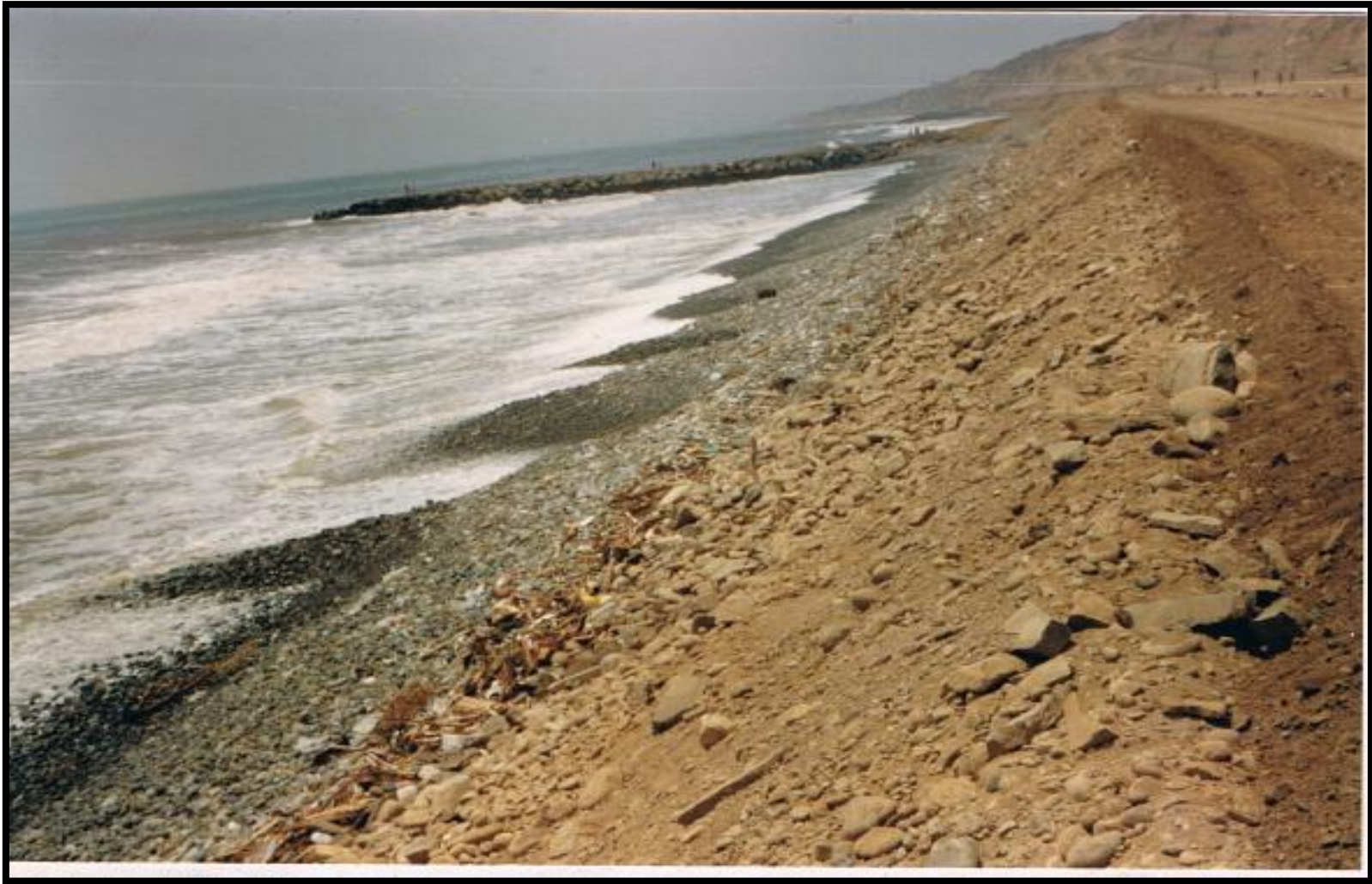
Foto 4: Vista hacia el espigón E2 mostrando cusps. Fuente: Propia.
