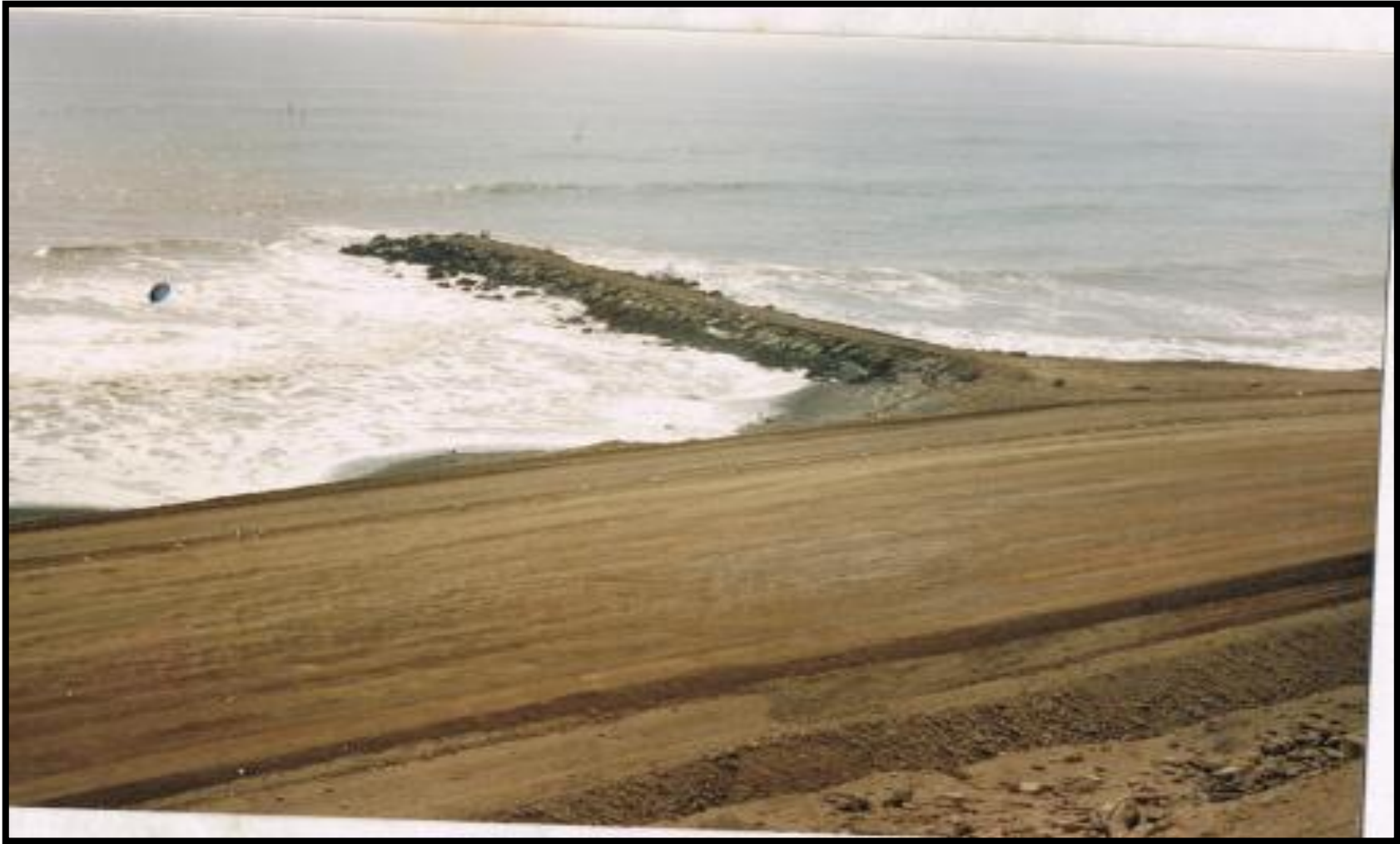
Foto 13 (a): Vista panorámica tramo E1-E2, desde Marbella. Fuente: Propia.
