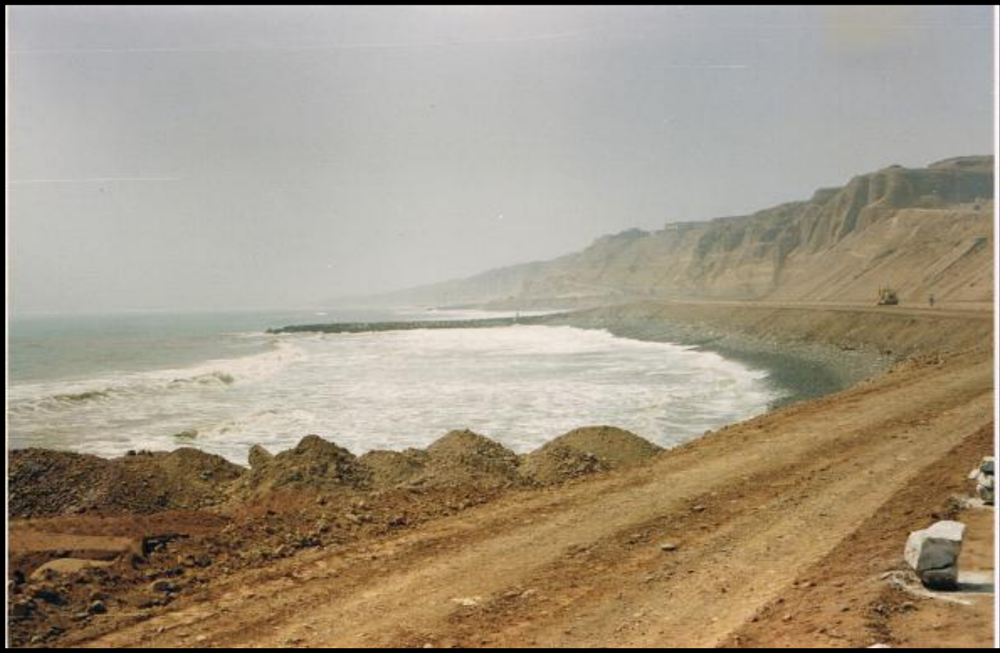
Foto 5: Tramo con talud 1:1 expuesto al embate de las olas. Fuente: Propia.
