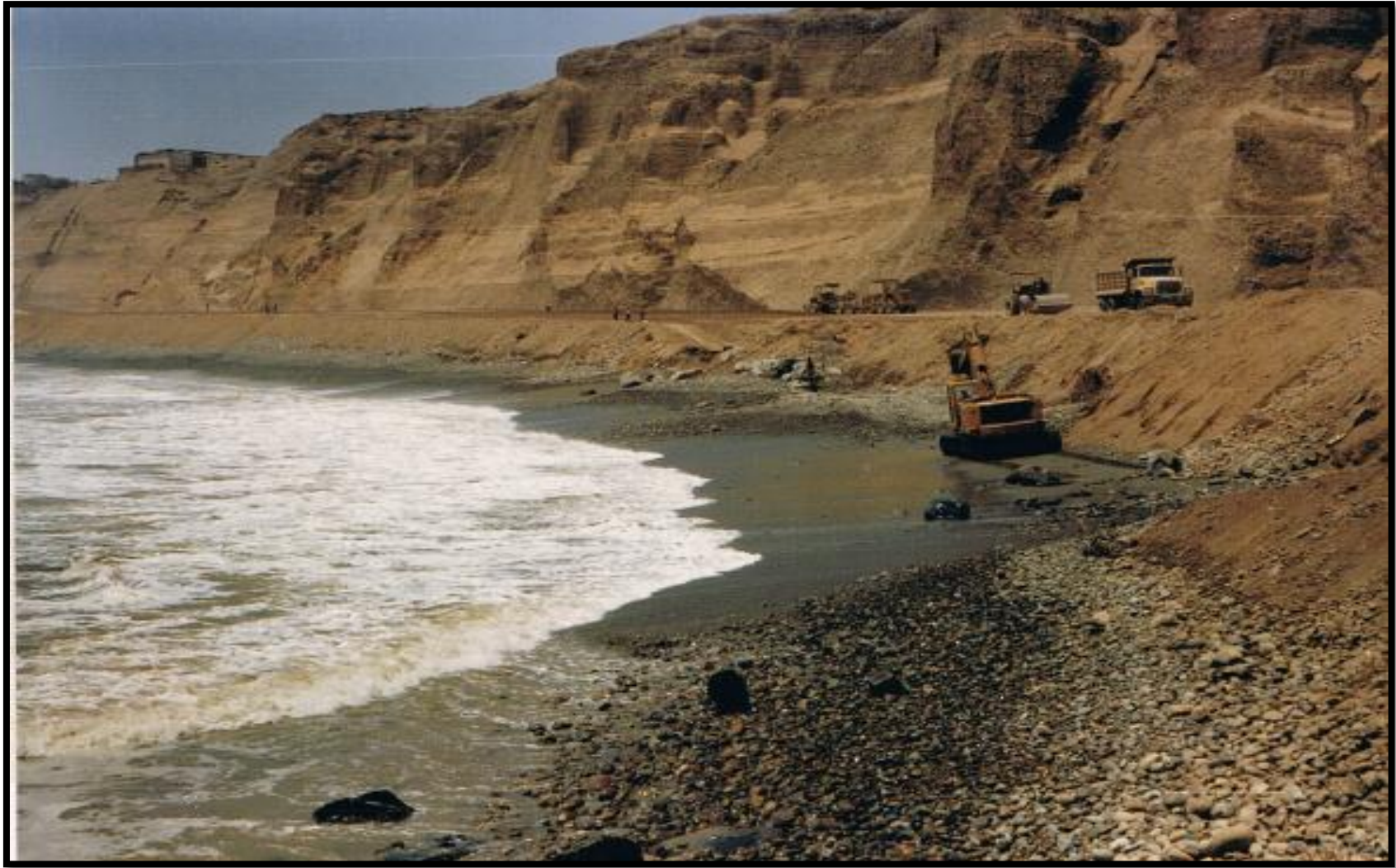
Foto 10: Revestimiento en el tramo E2-E3. Fuente: Propia.
