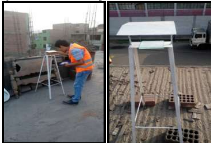
Figura N° 21: Placas Receptoras ubicadas en las Casetas
